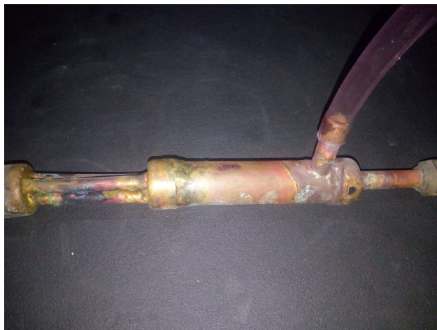
Figura 3.12: Unión con soldadura de 15 % plata.
