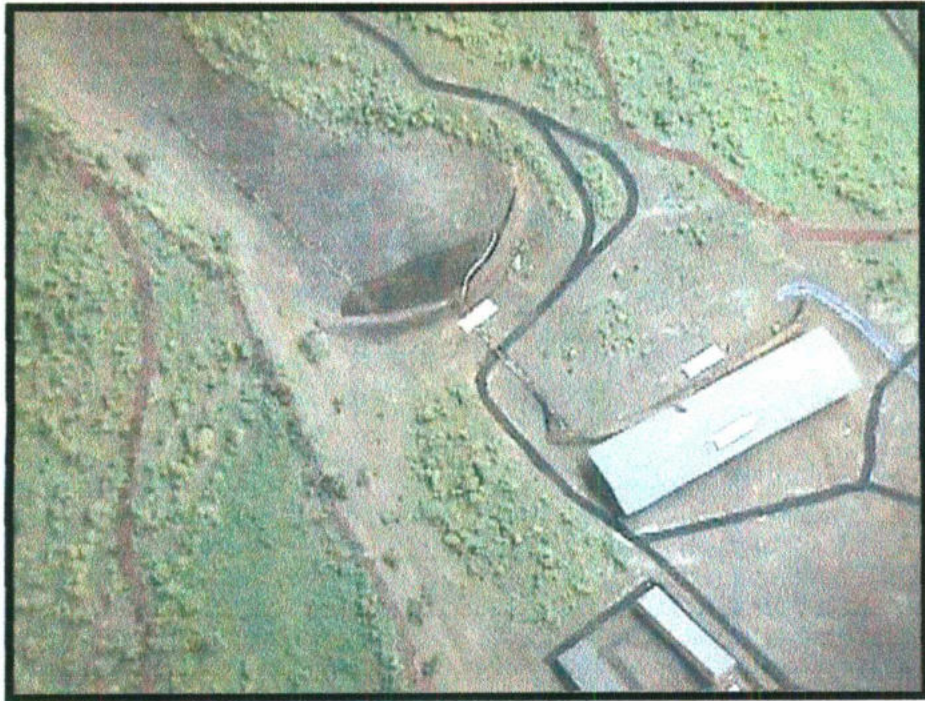
FOTO 15. Simulación de una avenida, en condiciones actuales, se puede ver el comportamiento del flujo del agua con los muros actuales.
