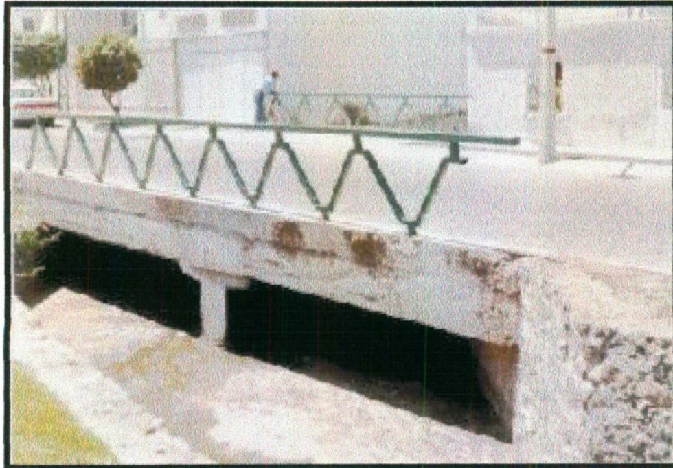
FOTO 9. En la foto se muestra la entrada del canal a la colonia El Marqués, mediante un canal rectangular que cruza a ésta.
