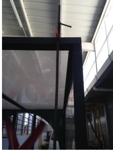
Figura 18.- Sujeción de la base del anemómetro al túnel de viento
