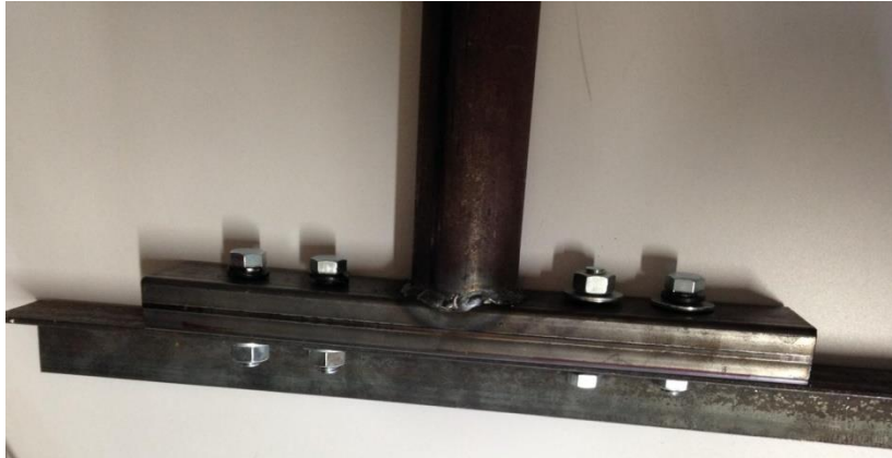
Figura 27. Base terminada vista frontal
