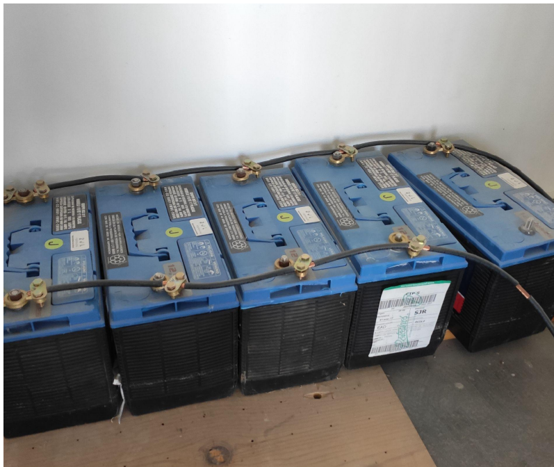
Figura 4.7. Instalación de banco de baterías (autoría propia).
