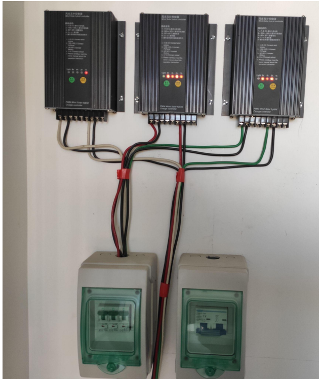
Figura 4.6. Instalación del conductor al regulador, con protecciones eléctricas a la entrada y salida del regulador (autoría propia).
