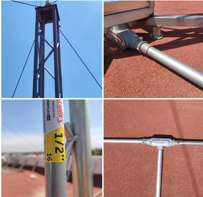
Figura 4.4. Canalización (autoría propia).
