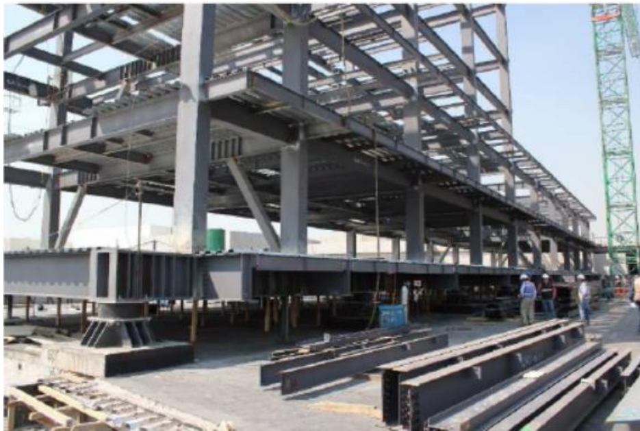
Figura 2.4. Aisladores en la base del edificio del hotel Vía Vallejo (Galindo et al., 2016).
