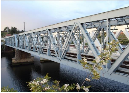
a) Puente a base de armaduras.
