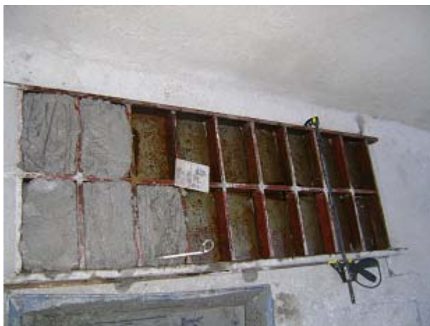
Fig. 20 Elaboración de tabiques por vaciado
