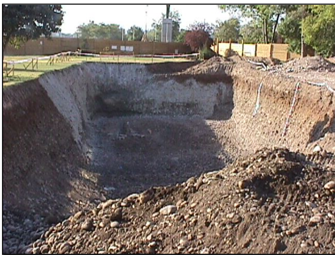
Figura 1.12 Fotografía de una excavación.
