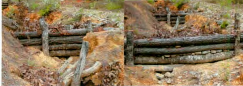
Figura. 21. Ejemplos de presas de morillos.
