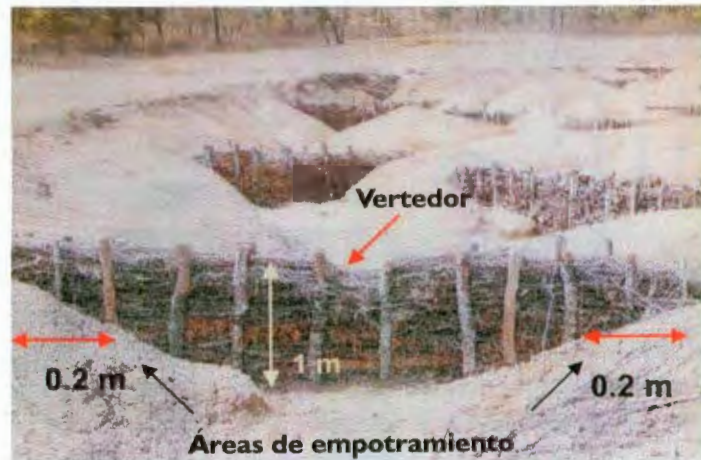
Figura.20. Diseño de presa de ramas en cárcavas.
