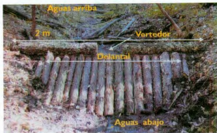
Figura. 24. Vista frontal del delantal en una presa de morillos.
