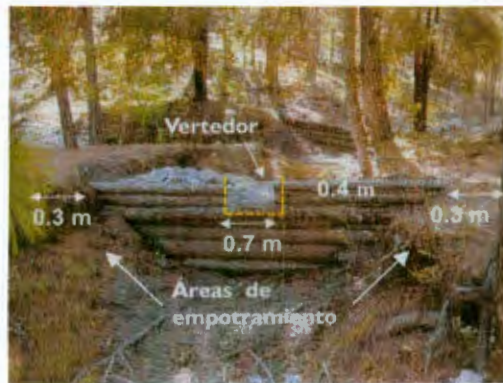
Figura. 23. Colocación transversal de morillos y formación del vertedor en una presa.
