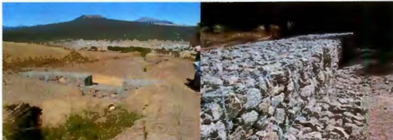
Figura. 36. Ejemplos de presas de gaviones.
