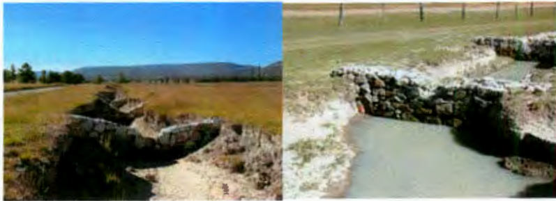
Figura.25. Ejemplos de presas de piedra acomodada.
