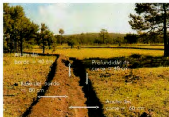
Figura. 35. Construcción de bordo para terrazas de formación sucesiva.
