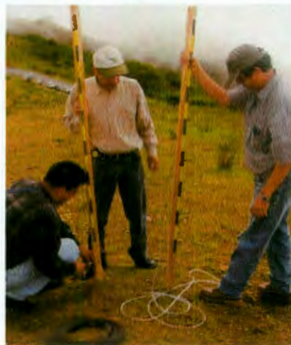
Figura.7. Nivel de manguera.
