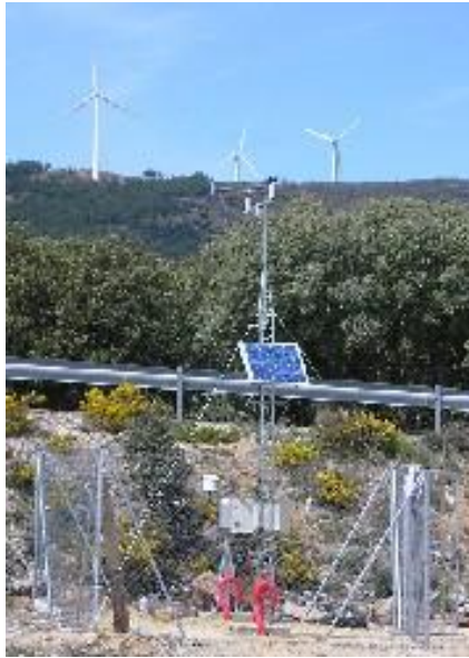
Figura 2 Estación RD32 marca SEAC (Cortesía de SEAC)
