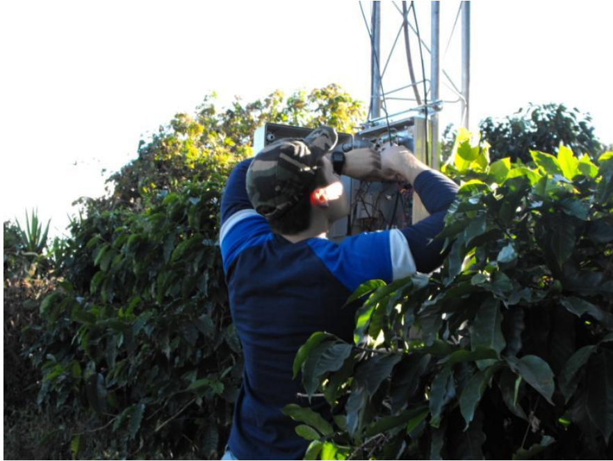
Figura 46 Conexión de los Sensores al SAD.
