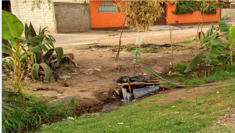
Figura 34. Bomba casera de agua hecha por un habitante de la localidad de El Salitre para extraer agua del manantial para su vivienda.
