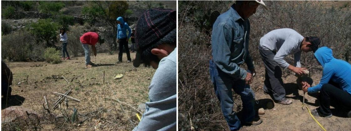
Fig. 8. Medición y marcaje con estacas para la colocación de polines.
