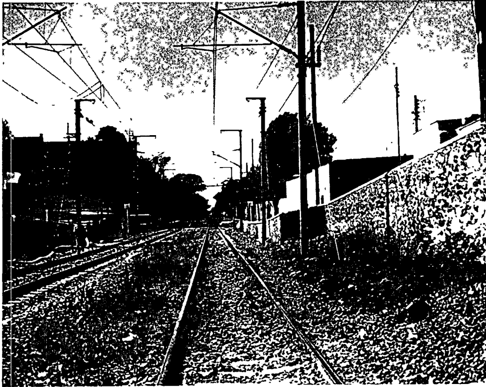
Figura 4.26. Vías en tangente, en el cruce ferroviario de la calle Invierno.
