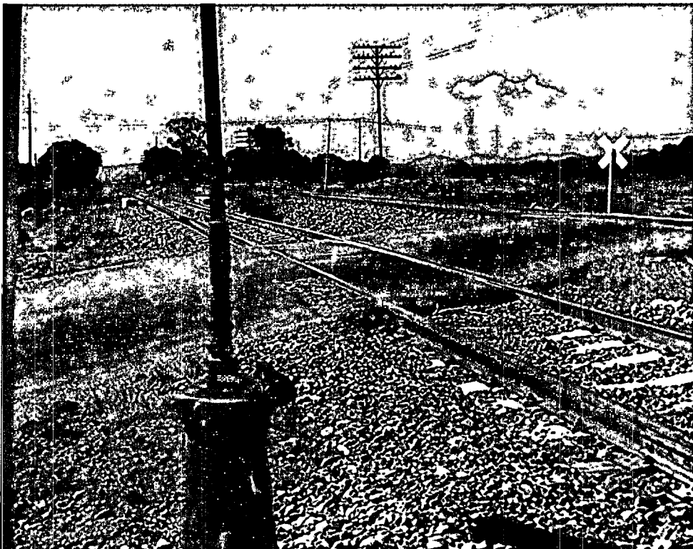
Figura 4.46. Aspecto general del cruce ferroviario.
