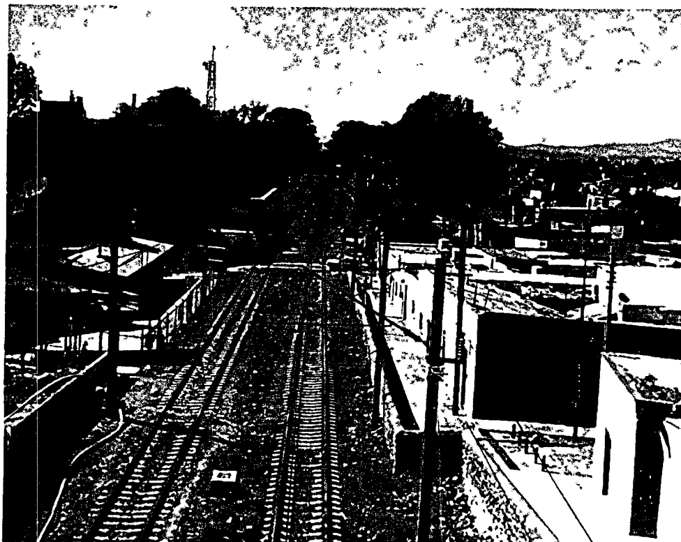
Figura 4.32. Zona adyacente al cruce de la calle Invierno.
