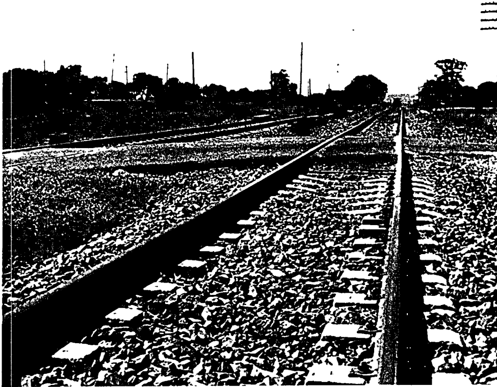
Figura 4.47. Aspecto general de los elementos de la vía en el cruce ferroviario.
