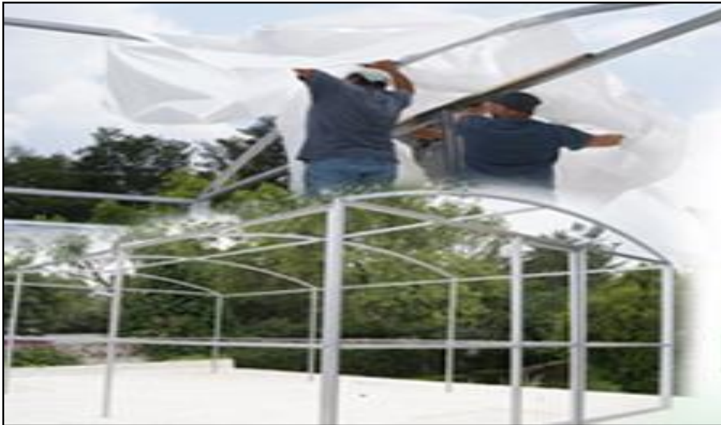
Figura 12. El acero principal material de un invernadero
