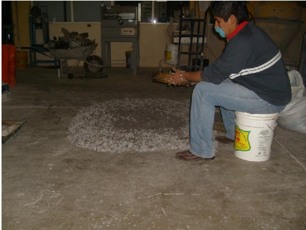
Figura 3-8 Proceso de cribado manual para obtener solo la fracción de arena.
