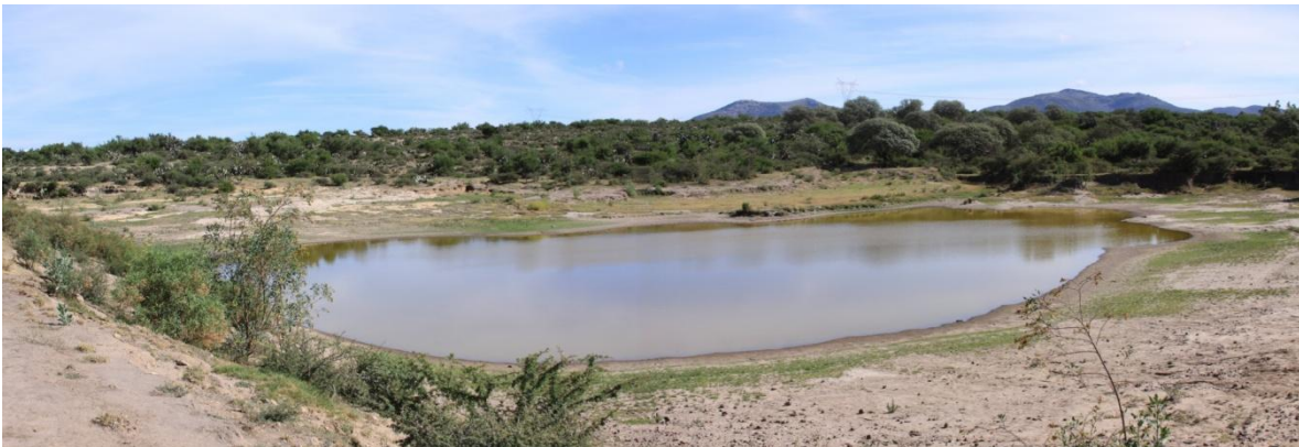
Figura 3.81. Bordo de regulación, parte alta de la cuenca.
