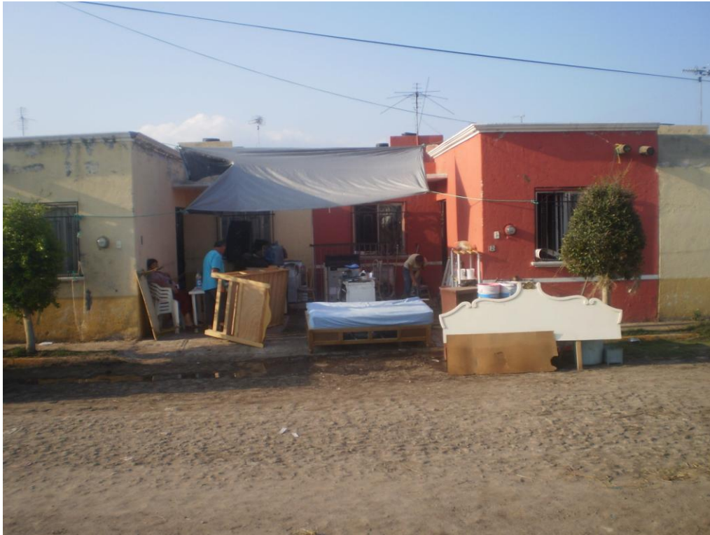
Figura 3.106. Inundación y afectación a zonas habitacionales cuenca baja.
