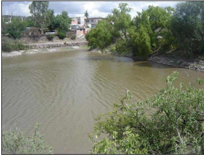
Figura 3.73. Vista general del bordo que se encuentra en la Calle Río Grande.
