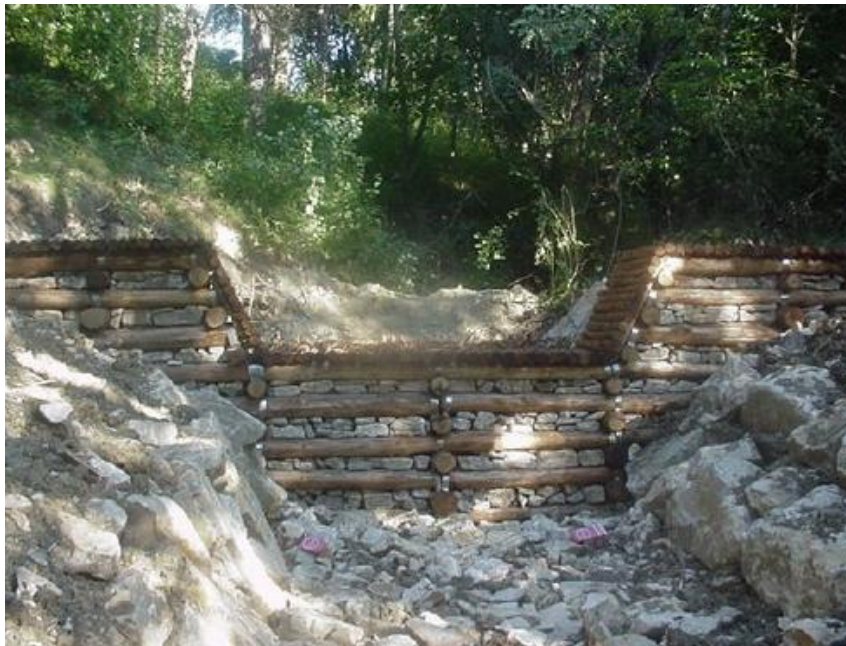
Figura 6.4. Presa filtrante de tronco y roca acomodada, obra de ingeniería naturalística. Fuente: Experiencia práctica, Provincia de Foggia, Sur de Italia, 2011.
