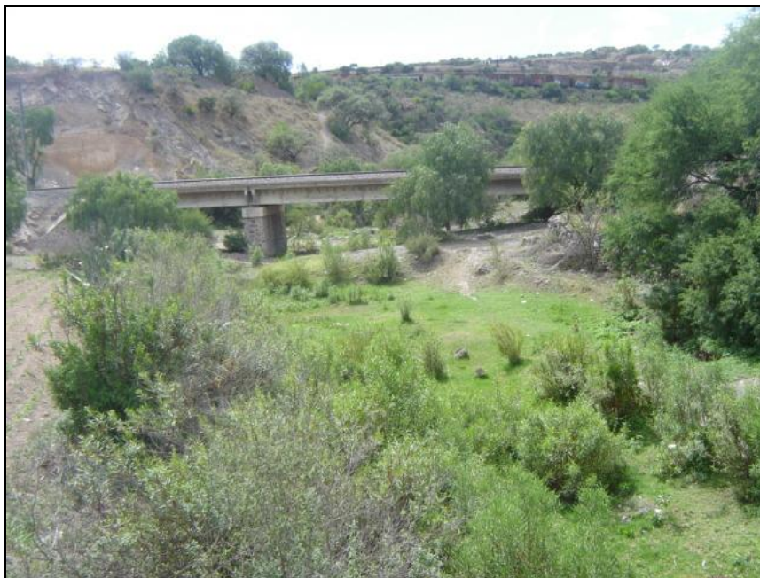
Figura 3.28. Aguas abajo de la ubicación del puente antes descrito, vista de cruce férreo, de mayor amplitud de área hidráulica.
