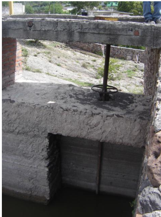
Figura 3.75. Vista de la compuerta alojada en el vertedor (en margen izquierda) que permite desfogar el bordo.
