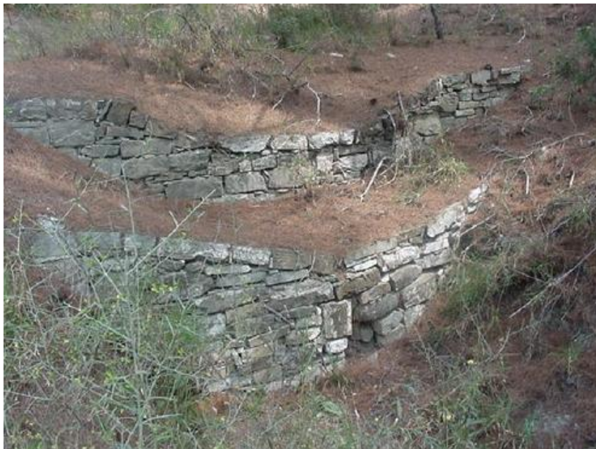
Figura 6.6. Presa estable de roca acomodada, obra de ingeniería naturalística.
