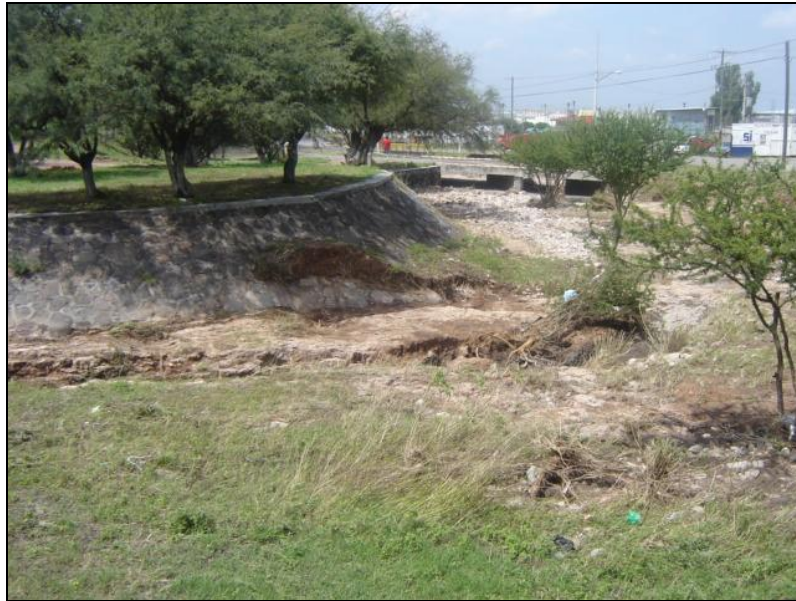
Figura 3.78. Vista del vertedor de excedencias localizado por la margen derecha del bordo Juárez.
