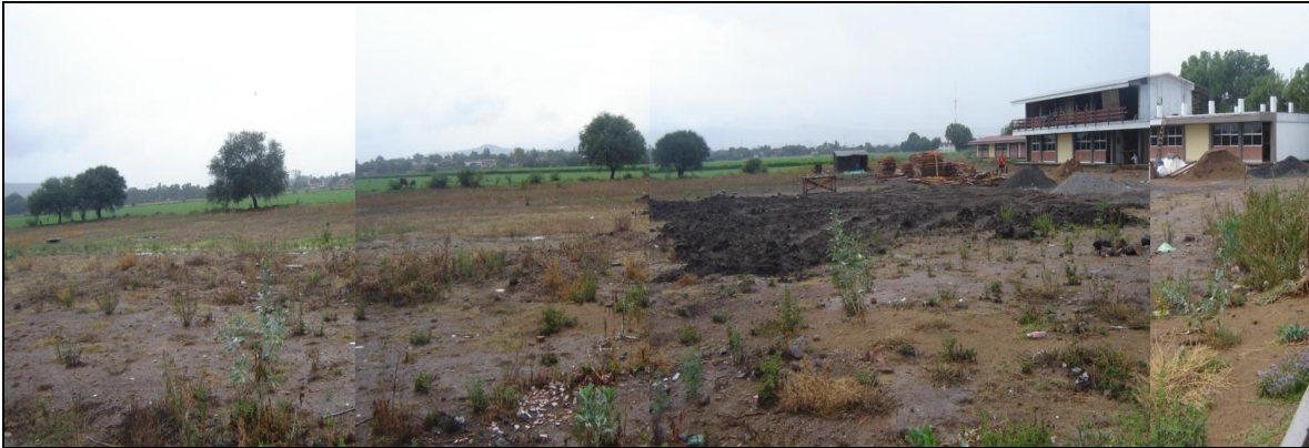
Figura 3.45. Instalaciones del centro educativo ubicado en la zona de influencia del vaso regulador.
