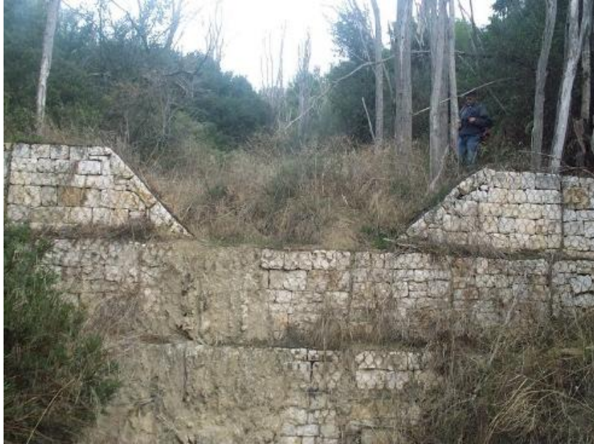
Figura 6.7. Presa estable de gavión de roca acomodada, obra de ingeniería naturalística. Fuente: Manual de ingeniería naturalística, en: http://www.regione.lazio.it/rl_ingegneria_naturalistica/ .
