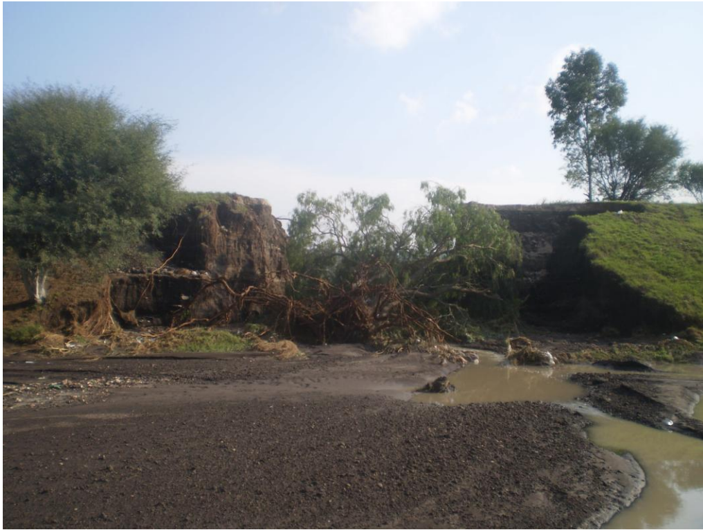
Figura 3.102. Rompimiento del Bordo Benito Juárez cuenca baja.
