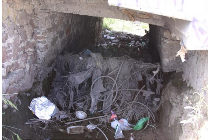
Figura 3.92. Porción del dren sin mantenimiento.
