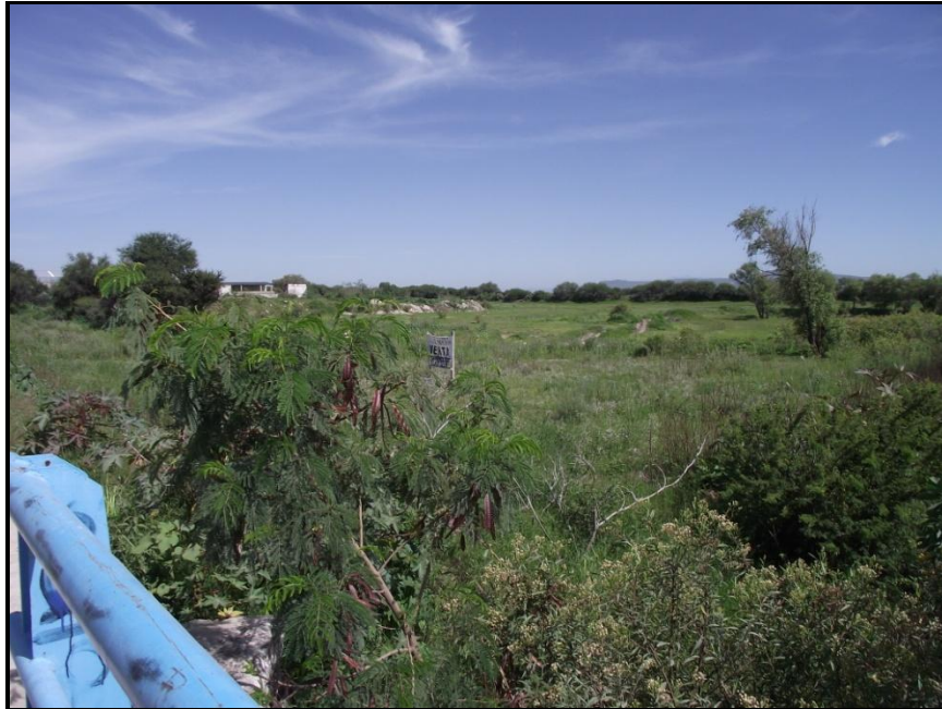
Figura 3.65. Vista aguas debajo de la alcantarilla de la Kimberly Clark, en la zona de inundación que funciona como vaso regulador.
