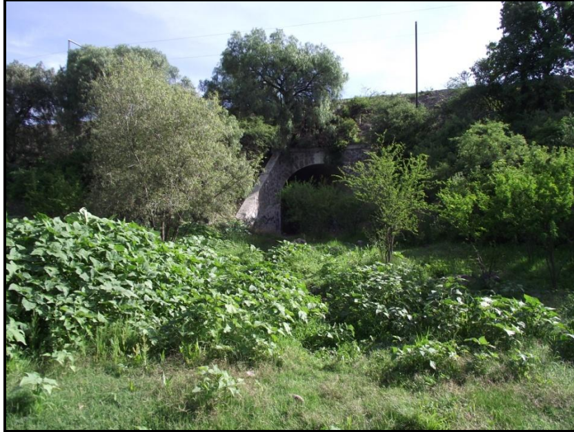
Figura 3.61. Alcantarilla aguas abajo del bordo.
