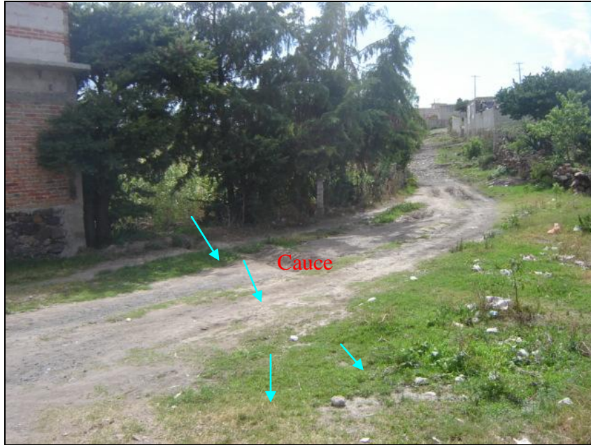
Figura 3.35. Vista de la forma en que el cauce se conduce por las calles.
