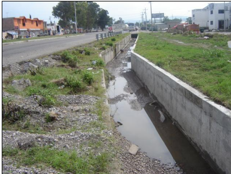
Figura 3.80. Vista del dren de concreto localizado en la Avenida Constitución.
