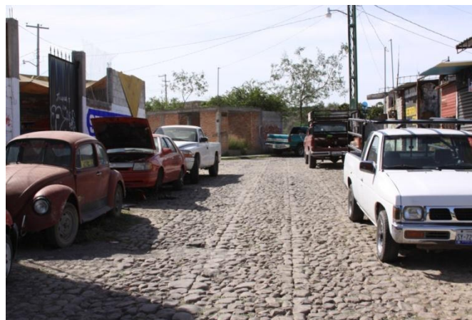
Figura 3.93. Vialidades empedradas en cuenca alta, que ayudan al comportamiento del escurrimiento.
