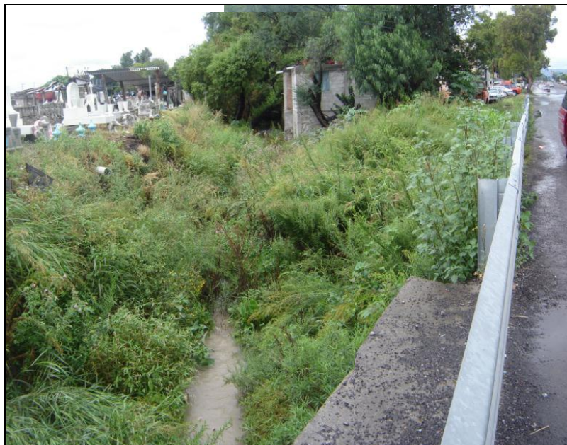
Figura 3.51. Vista del cruce del arroyo Xhosda, en su intersección con la carretera a Tequisquiapan.
