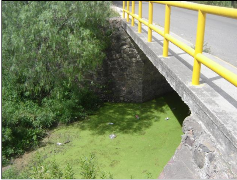
Figura 3.27. Vista de puente vehicular sobre el dren Banthí, en la localidad Paso de Mata.
