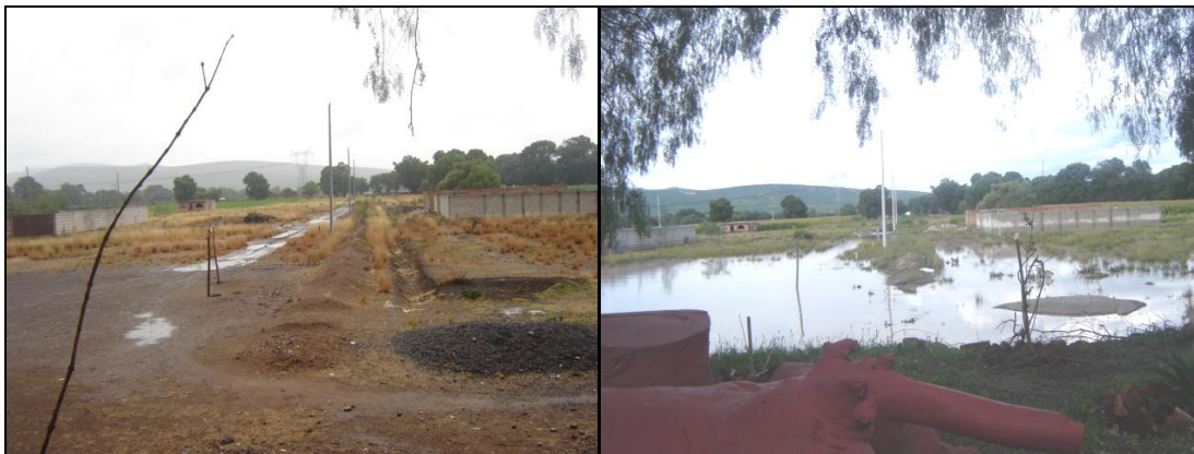
Figura 3.42. Vista comparativa general del bordo en San Pedro Ahuacatlán, invadido por asentamientos e infraestructura, ante un evento de inundación del vaso.
