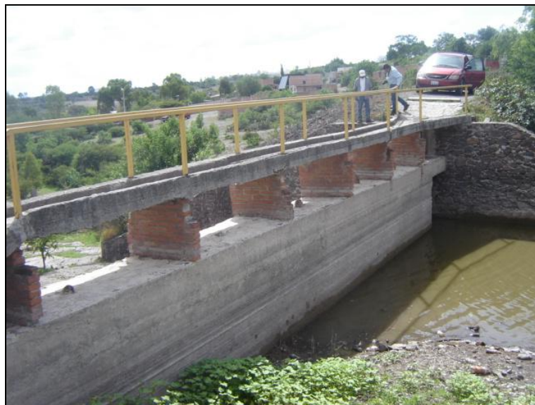
Figura 3.74. Vista del vertedor existente por la margen izquierda del bordo.
