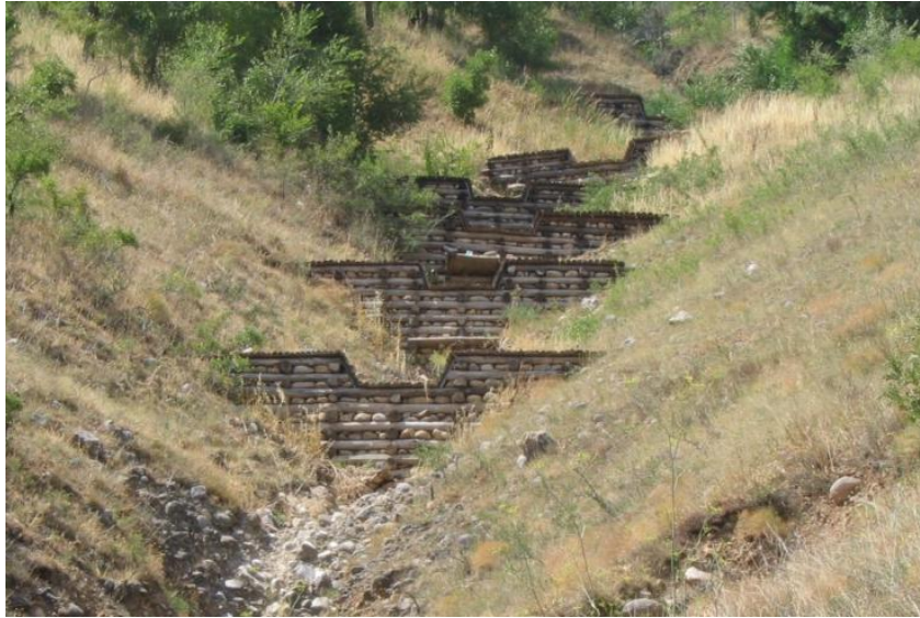
Figura 6.5. Presa filtrante estable de tronco y roca acomodada, obra de ingeniería naturalística.
