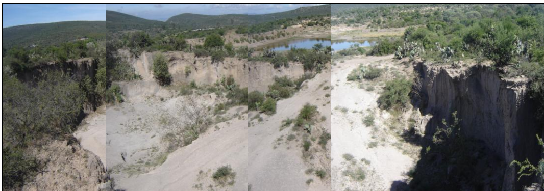
Figura 3.16. Vista general de un bordo de abrevadero, que cumple con funciones de retención de azolve, aunque puede representar un punto de riesgo en caso de rompimiento de la estructura.
