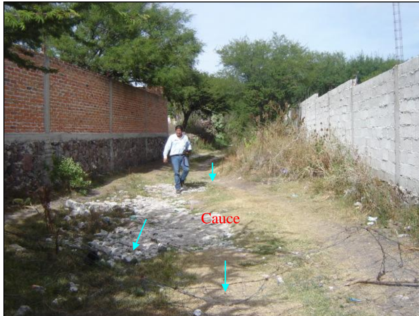
Figura 3.36. Invasión de la zona federal con construcciones de los vecinos de la localidad.
