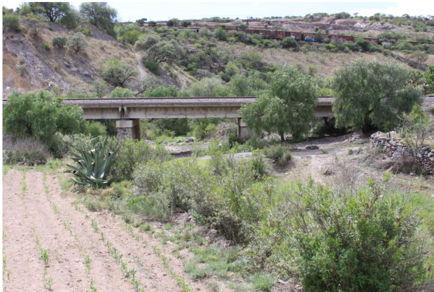
Figura 3.87. Paso de vías de ferrocarril, estructura realizada mediante estudio hidrológico.
