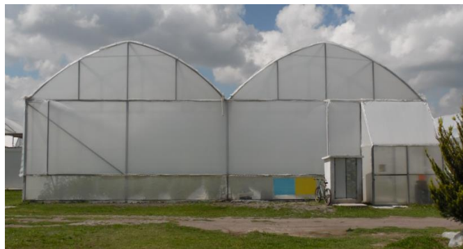
Figura 4.1. Vista frontal de la pared norte del invernadero. Techo tipo capilla estilo gótico, a dos naves. A la derecha se encuentra la caseta de control del sistema de fertirriego y contigua a la caseta la entrada de puertas dobles al invernadero.
