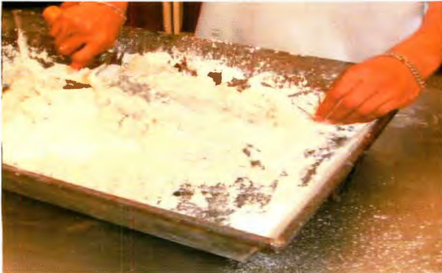
Figura 3. Preparación del mortero.
