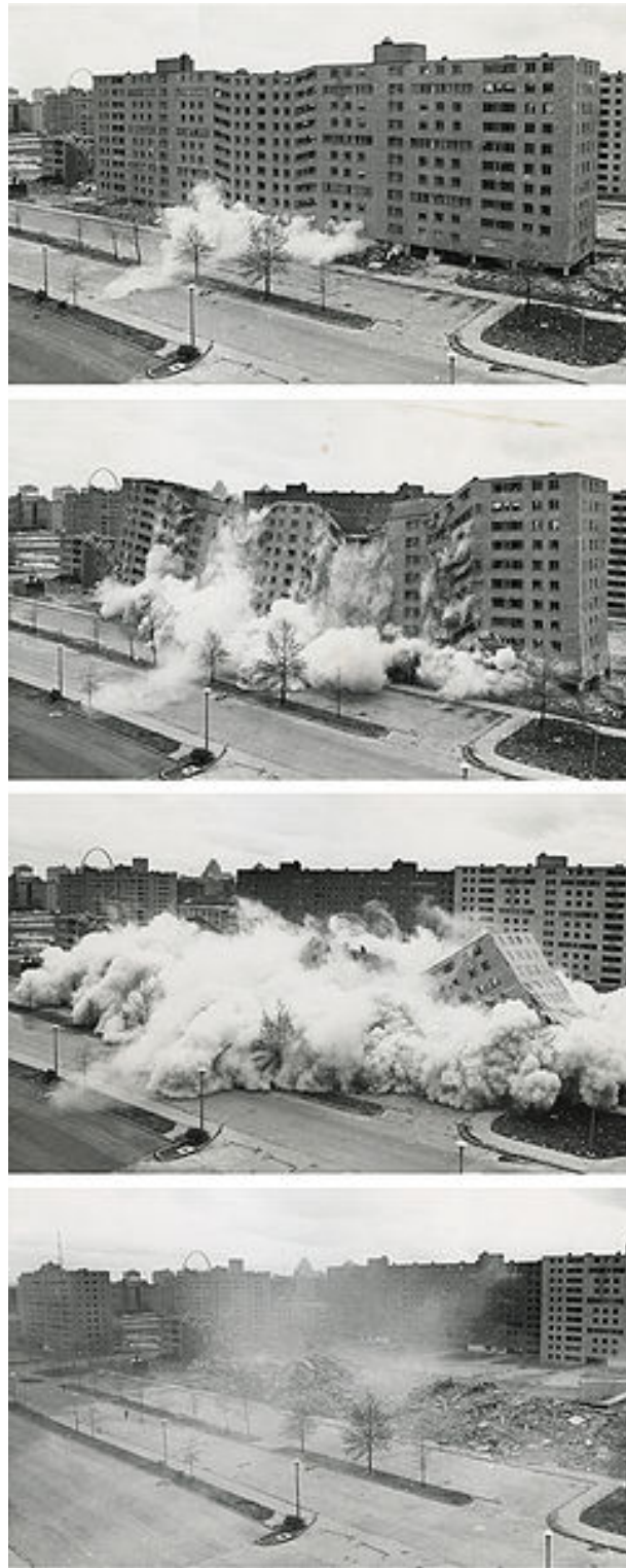
Figura 15. Minoru Yamasaki. Secuencia de la demolición de Pruitt Ingoe. Saint Louis, Missouri. 1972.
