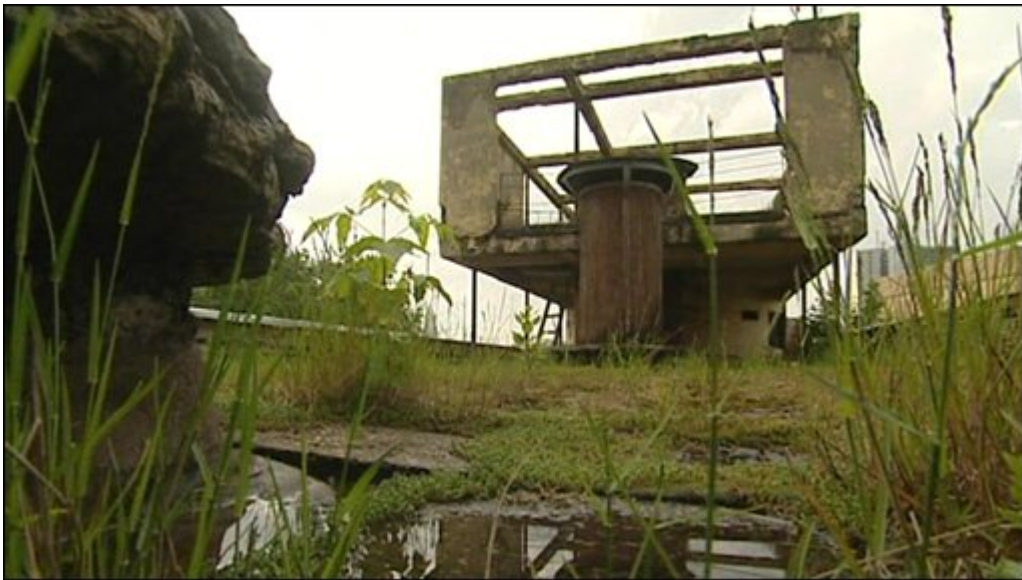
Figura 17. Moisei Ginzburg. Azotea/terraza de Narkomfin. Moscú, 1928-32.
