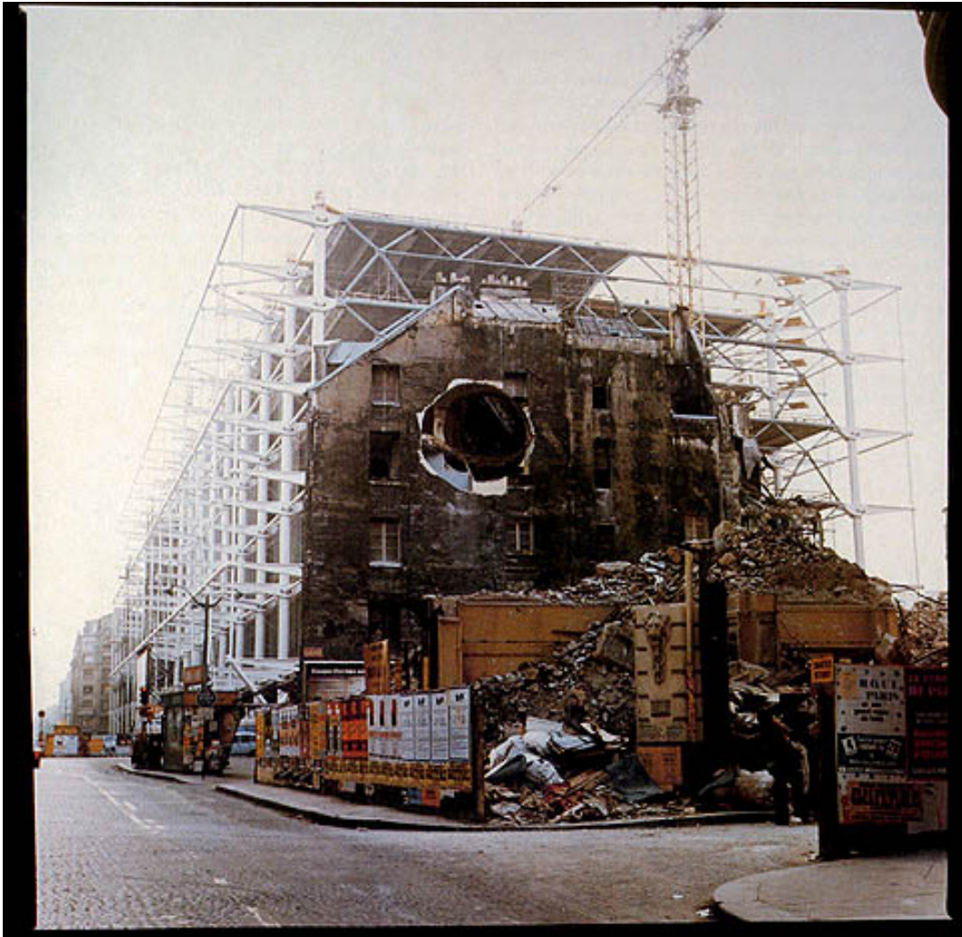
Figura 12. Gordon Matta-Clark. Conical Intersect con el Centro Pompidou en construcción al fondo. 1975.
