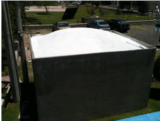
Figura 14: Cuarto de control terminado de construir.
