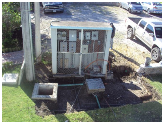
Figura 13: Cuarto de control terminado de construir.
