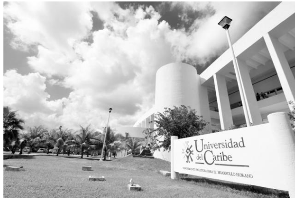
Figura 7. Instalaciones de la biblioteca de la Universidad del Caribe.
