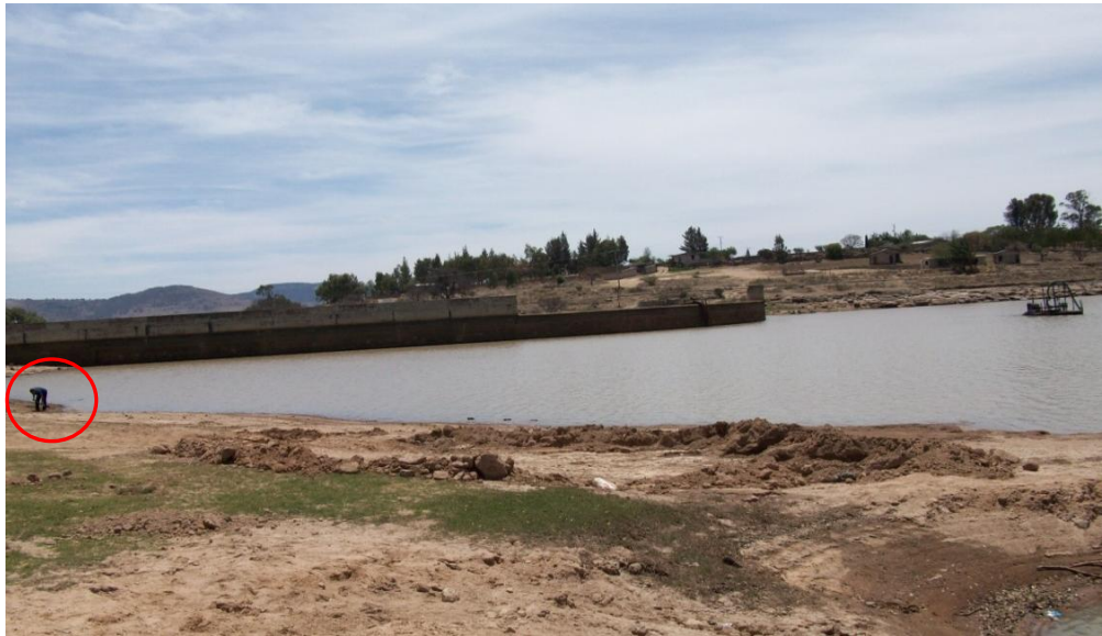
Figura 4.4 (b) Vista general de la presa San Pedro Huimilpan, Querétaro, vista desde aguas arriba. Por el nivel de agua, se aprecia parte del azolve depositado por margen izquierda, cerca del sitio (círculo) donde se hicieron muestreos.
