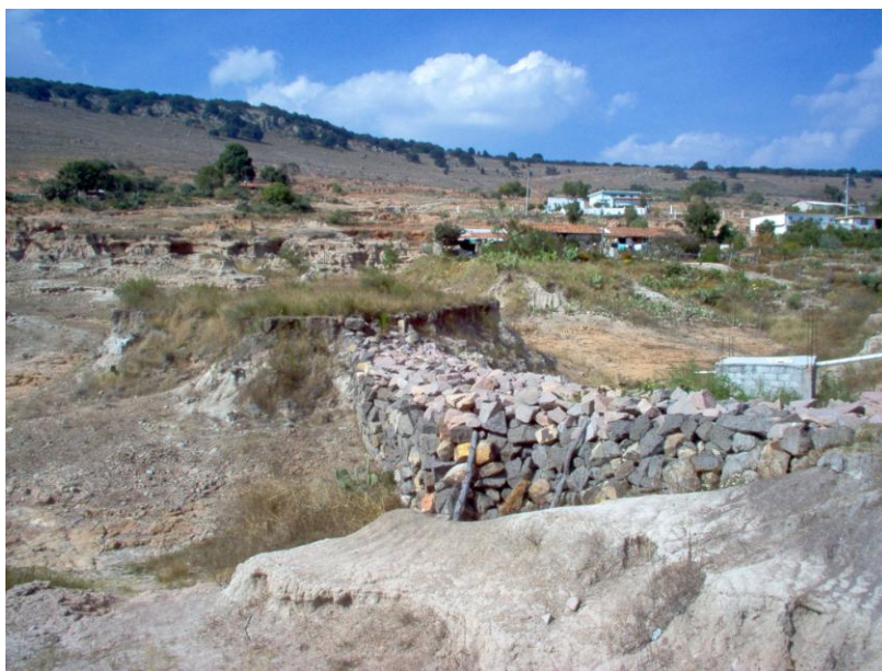
Figura 4.3 Zona erosionada en la cuenca alta del arroyo San Pedro, Huimilpan (Qro.) donde, además de los asentamientos humanos, se observa una clara desforestación en las áreas de lomerío. Si bien existen (indirectamente) ciertas obras para control de la erosión (primer plano), el deterioro parece excesivo.
