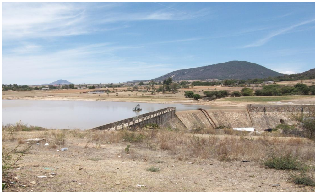
Figura 4.4 (a) , Vista general de la presa San Pedro Huimilpan, Querétaro, en la que se aprecia la cortina y el vertedor de excedencias (de cresta curva), al centro de la estructura. La fotografía permite observar parte del vaso y una panorámica de la cuenca, con cierta degradación de su cobertura vegetal.
