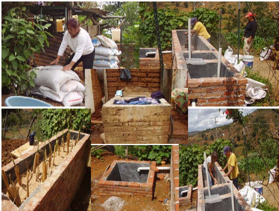
Figura 34. Construcción del humedal artificial
