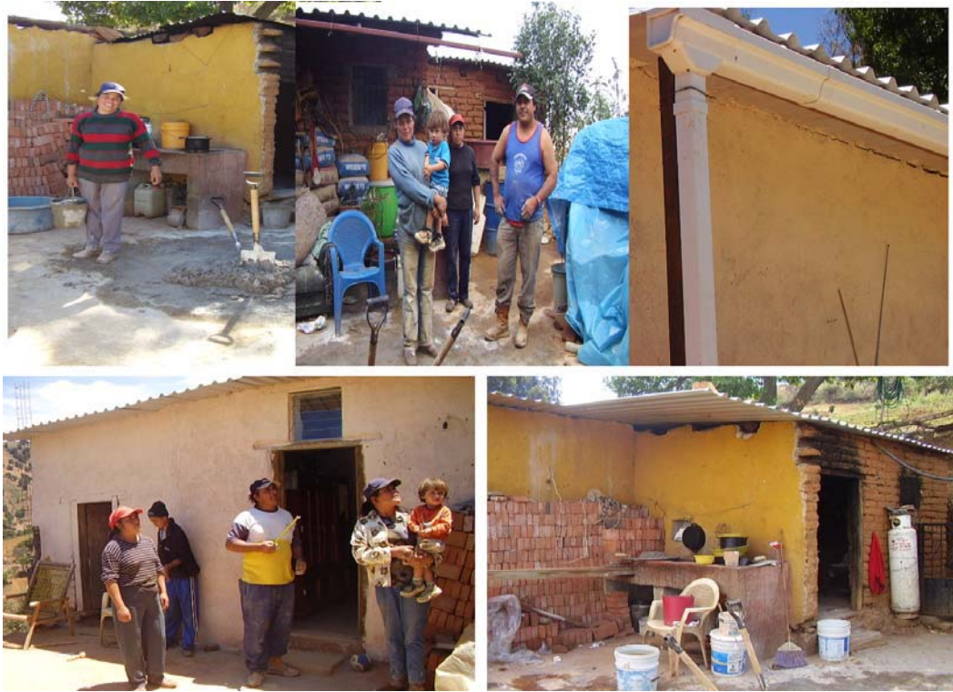
Figura 31. Preparación para colocación de canaletas.
