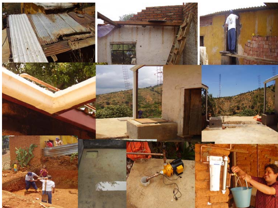
Figura 35. Etapas de construcción
