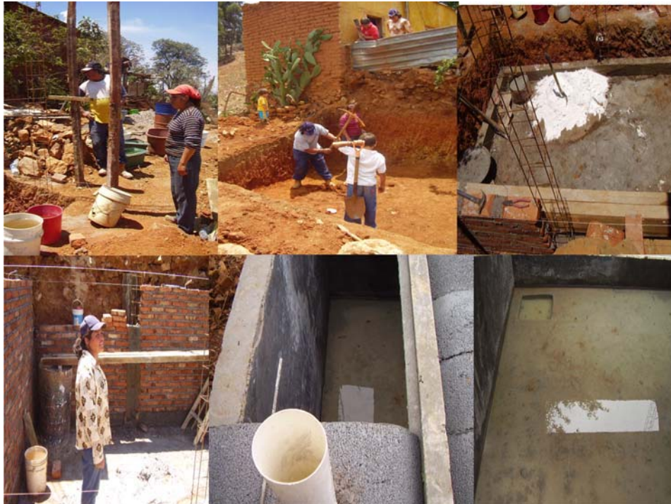
Figura 33. Excavación para construcción de cisterna.
