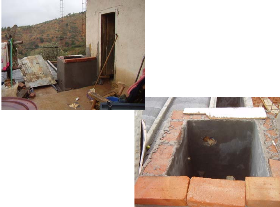
Figura 32. Construcción del sedimentador
