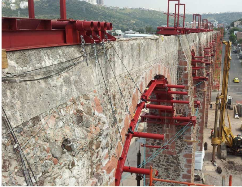
Figura 99. Estructura de Seguridad del Acueducto.
