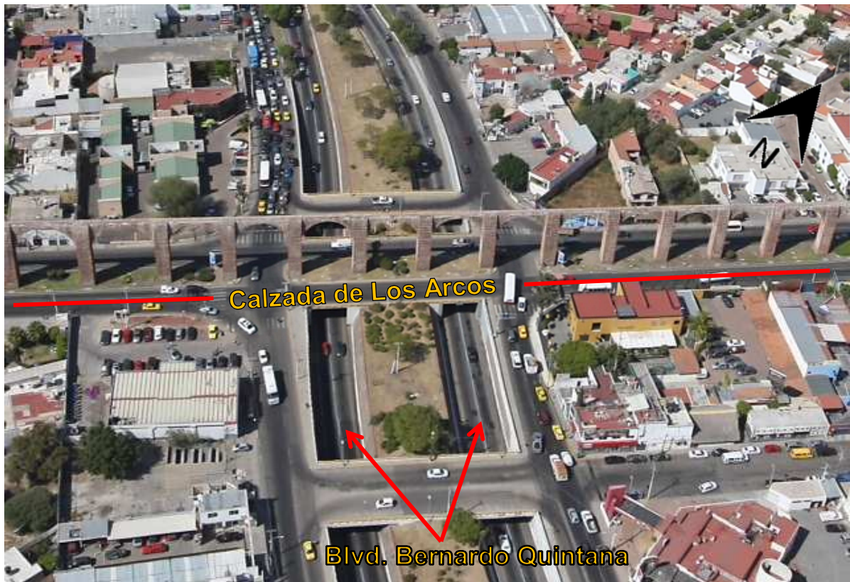
Figura 1. Estado inicial de la intersección.
