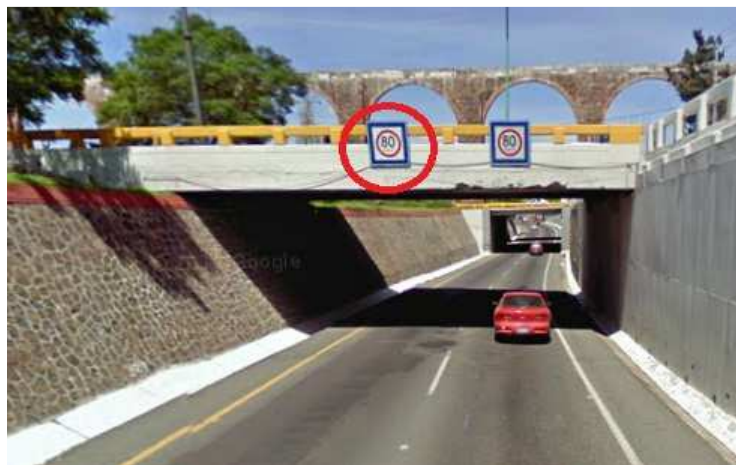
Figura 59. Señalamiento de velocidad máxima en paso inferior.
