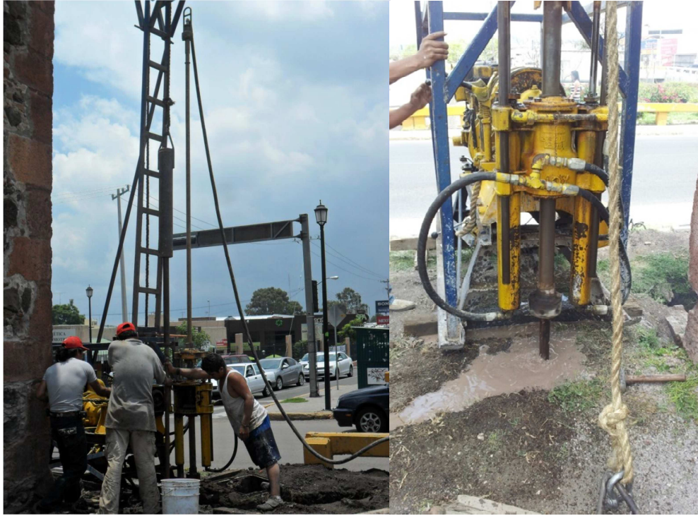
Figura 64. Prueba de Penetración Estándar (SPT).
