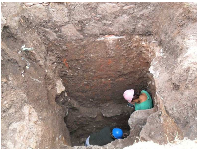
Figura 62. Exploración de Cimentación de Pilastra mediante PCA.
