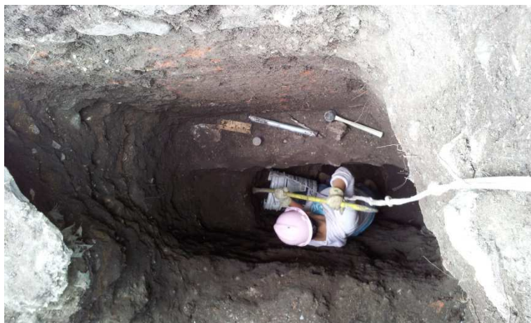
Figura 63. Recolección de muestras alteradas.
