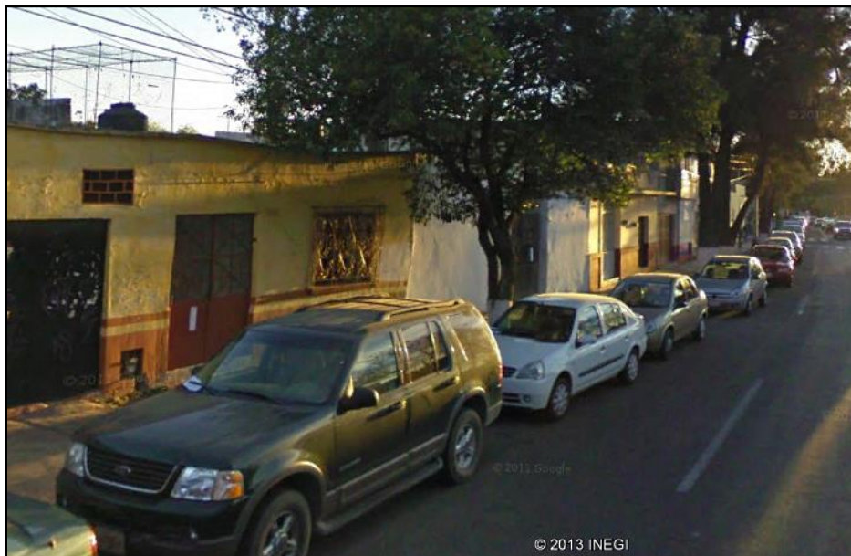
Figura 3.4.- Av. Universidad antes del proyecto “Regeneración de avenida Universidad”. Tramo: Melchor Ocampo – Calle Navidad. Fuente: Google Earth.
