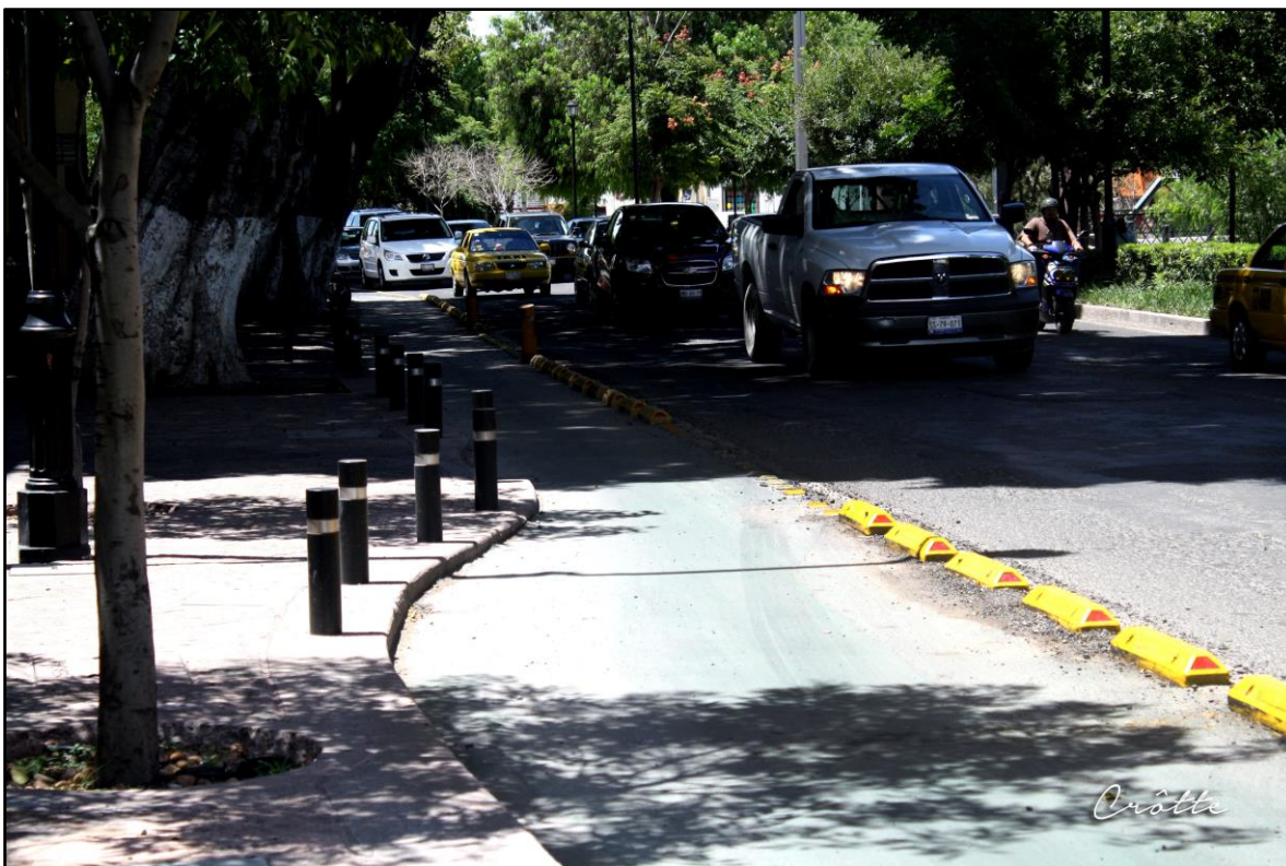
Figura 2.3.- El carril segregado para bicicleta en Avenida Universidad, Querétaro, Querétaro; México. Fotografía por Estefanía Crôte.
