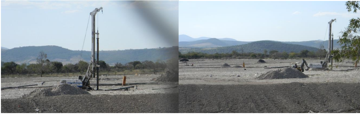
Imagen 27.- Perforadora encargada de realizar los distintos conductos de ventilación, a fin de crear respiraderos para los residuos enterrados.
