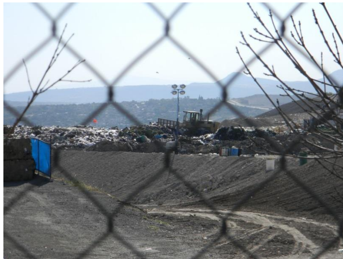
Imagen 26.- División entre oficinas y extensión del relleno sanitario mediante una zanja.
