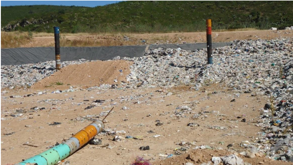
Imagen 33- Vista externa del Relleno Sanitario, donde se observa la acumulación de basura y chimeneas para el flujo de gases.
