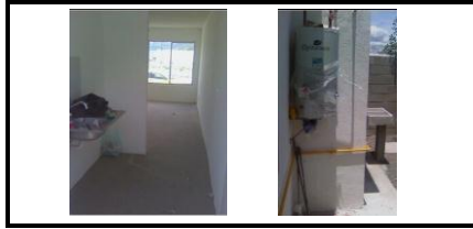
COCINA - PATIO TRASERO
