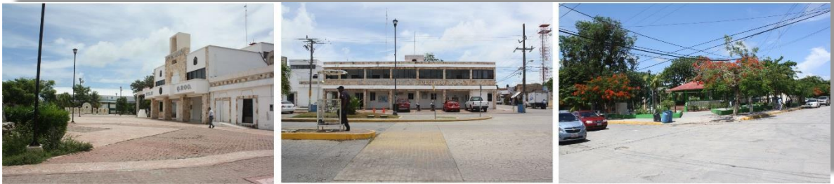
Imagen 10. Izquierda: Vista de la plaza al lado de la Presidencia Municipal; al fondo, el Domo Deportivo. Centro: Oficinas del Ayuntamiento Municipal. Derecha: Parque central. Fotografías propias. Marzo 2013.
