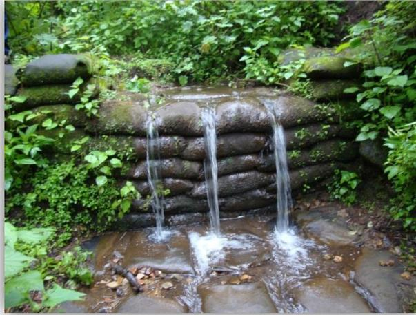
**Imagen 3.7.** Vista de una Presa de Geocostales implementada en un cauce de primer orden de la microcuenca “El Ventilador”.
