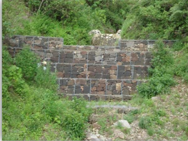
**Imagen 3.10.** Vista frontal de una Presa de Gavión, implementada en un cauce de segundo orden en la microcuenca “El Ventilador”.
