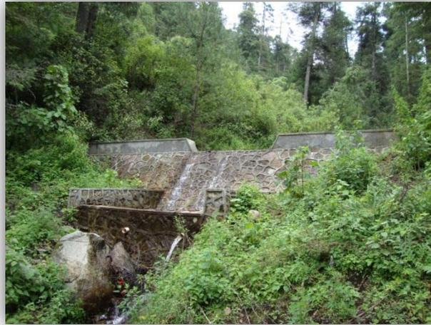
**Imagen 3.9.** Vista de una Presa de Mampostería, construida sobre el cauce 1 en la microcuenca “El Ventilador”.
