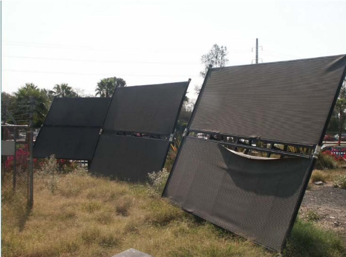
Fig. 3.1.1. Calentadores solares planos flexibles del invernadero de la Facultad de Ingeniería de la UAQ.
