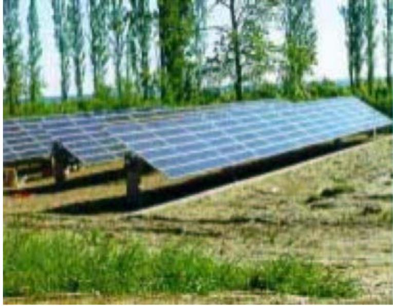
Fig. 2.3.3. Arreglo de paneles fotovoltaicos con orientación de un eje
