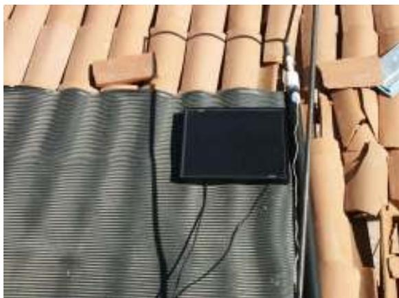
**Fig. 4. Este es el ejemplo de colocación del panel FV sobre el colector plano**
