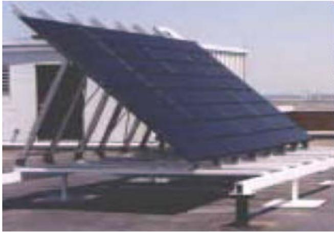
Fig. 2.3.1. Calentador solar plano con orientación fija de 45 grados hacia el sur
