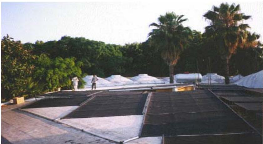
Fig. 2.2.3. Calentadores solares planos de orientación fija, para albercas.
