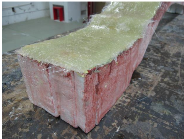
Figura 45 Colocación de fibra de vidrio y resina.
