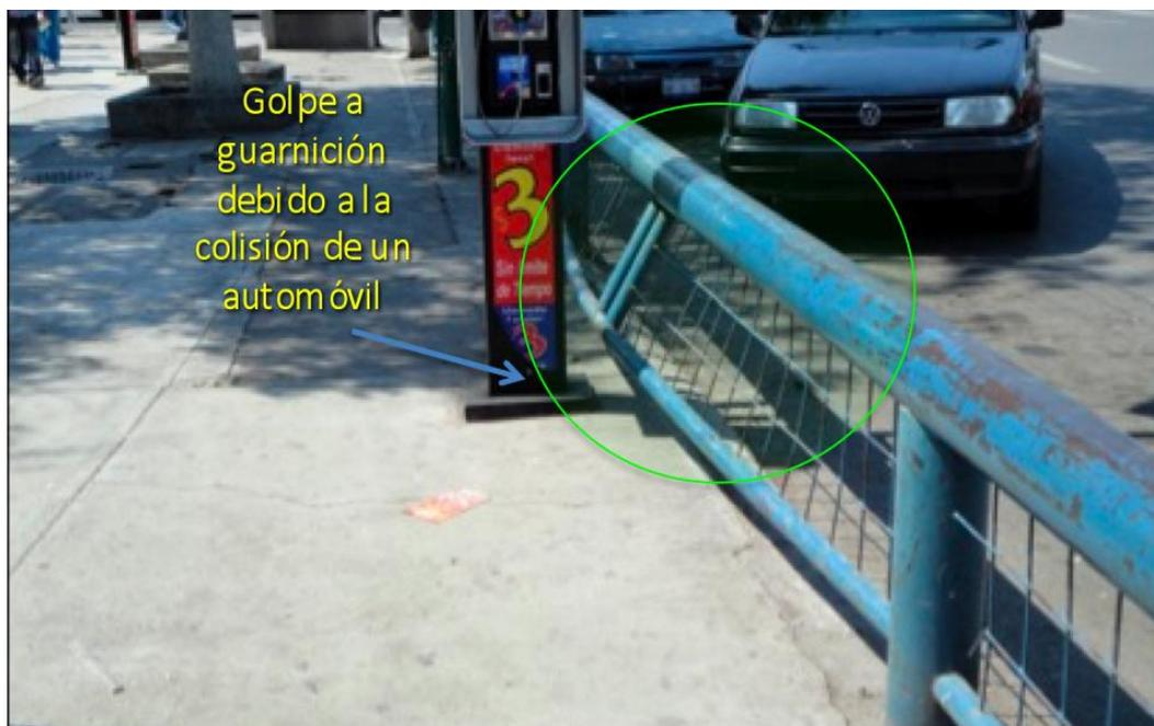
Figura 37 .- Guarnición metálica golpeada por un automóvil. Paradero ubicado en la Av. Zaragoza, a un lado del I.M.S.S
