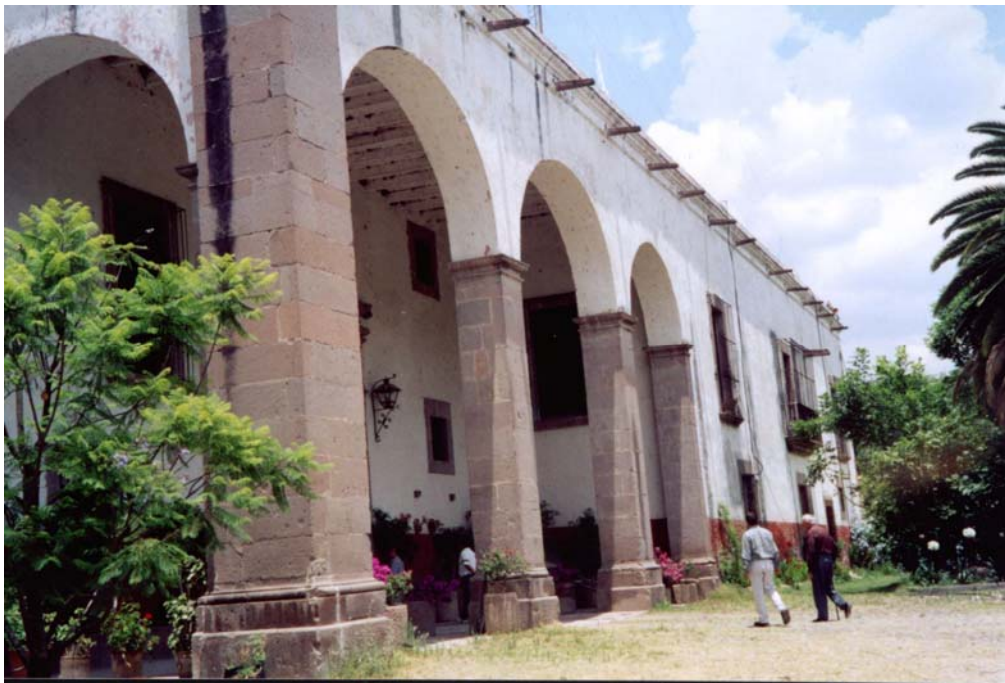
Figura 5. 3 Fachada principal de la antigua hacienda jesuita de San Francisco Javier de la Barranca
