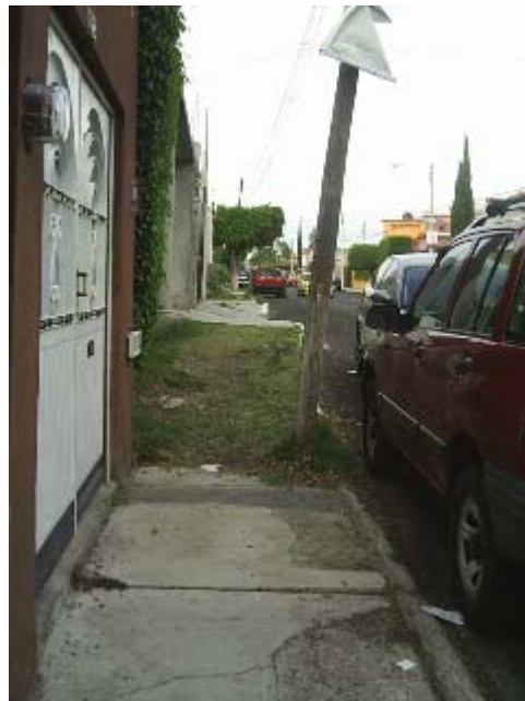
Foto VIII.11 Infraestructura en calle Hacienda Chichimequillas, afectada por Grieta 4 (“Jardines”)
