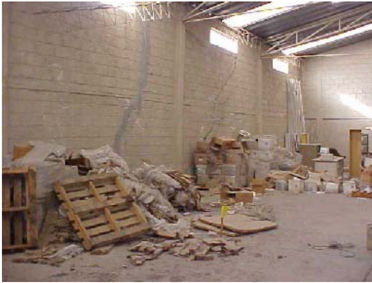
Foto VIII.2 Vista interior del inmueble anterior
