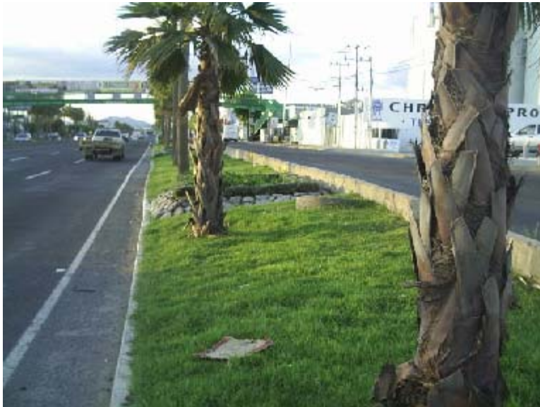
Foto VII.3 Daños causados en infraestructura por la grieta 1 (“5 de Febrero”)
