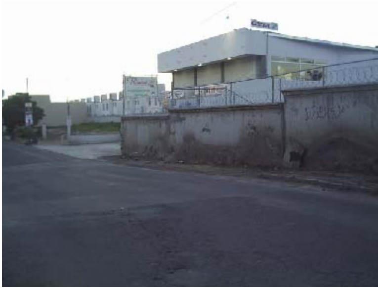
Foto VII.4 Cruce de la grieta 4 (“ Jardines”) por la Calle Prol. Pino Suárez
