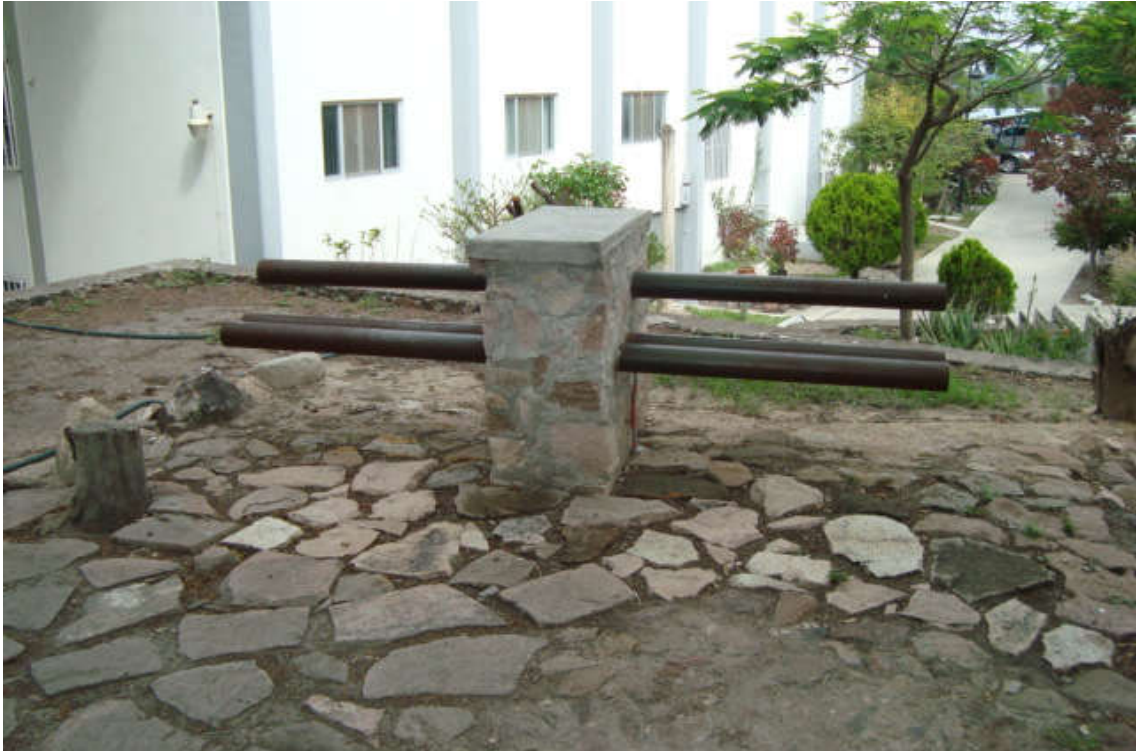
Figura 3.22. Asiento de concreto y metal ubicado afuera de el Edificio D.
