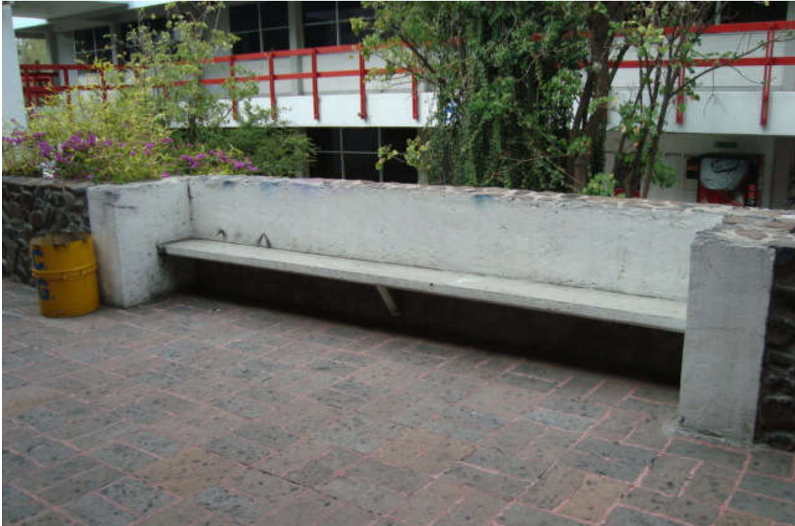
Figura 3.20. Asiento de concreto ubicada afuera de el Edificio B.
