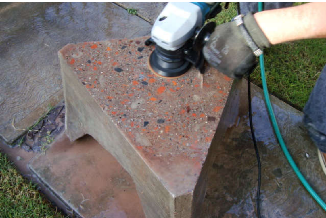
Figura 4.16. Textura del material una vez devastada la superficie.
