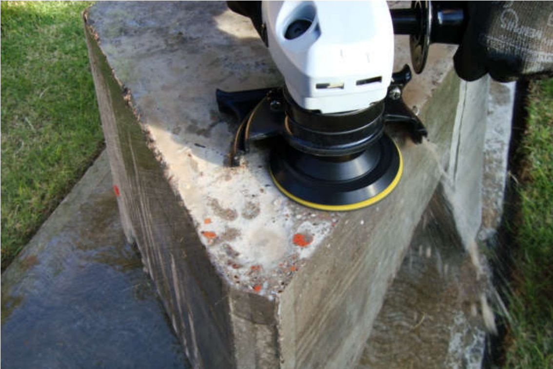
Figura 4.15. Pulido de la capa exterior de la parte superior de la pieza utilizando herramienta especializada para concreto y piedra.
