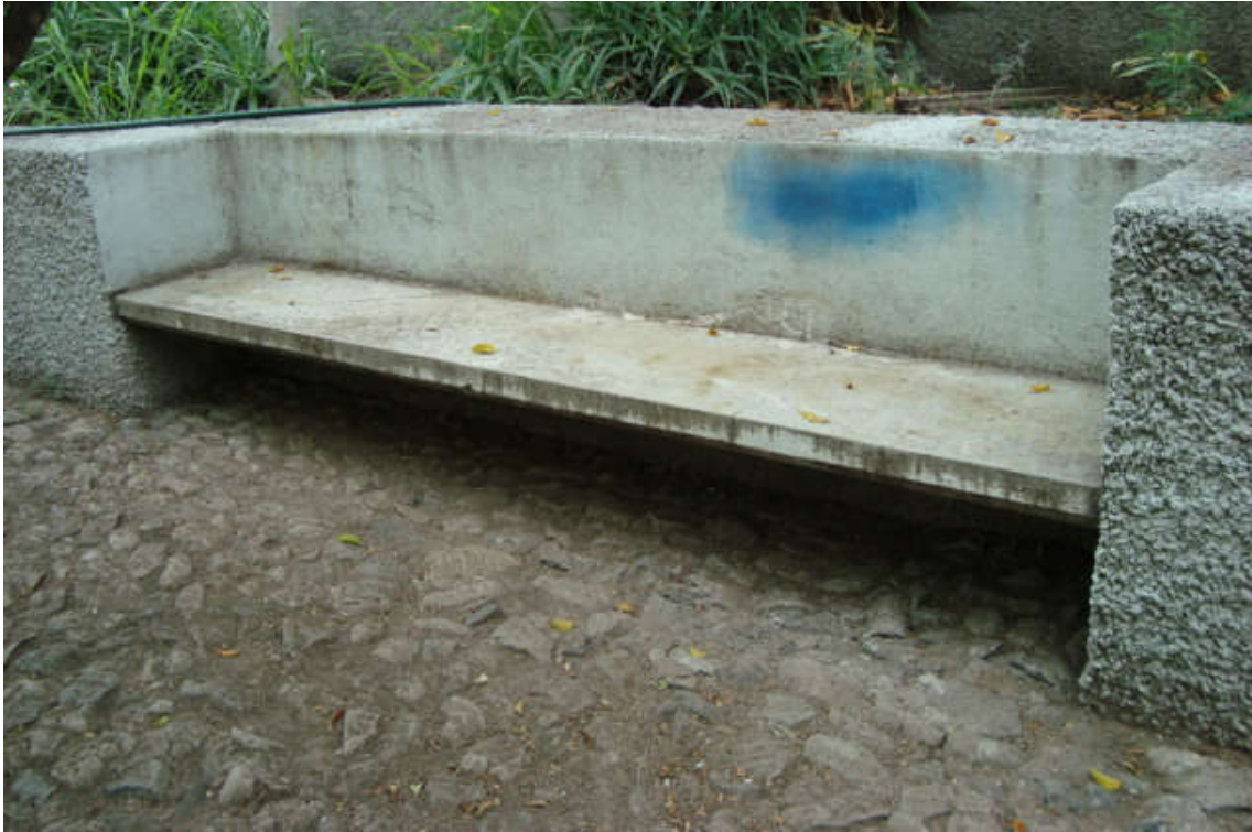
Figura 3.8. Banca de concreto ubicada en el “Bosquecito”.
