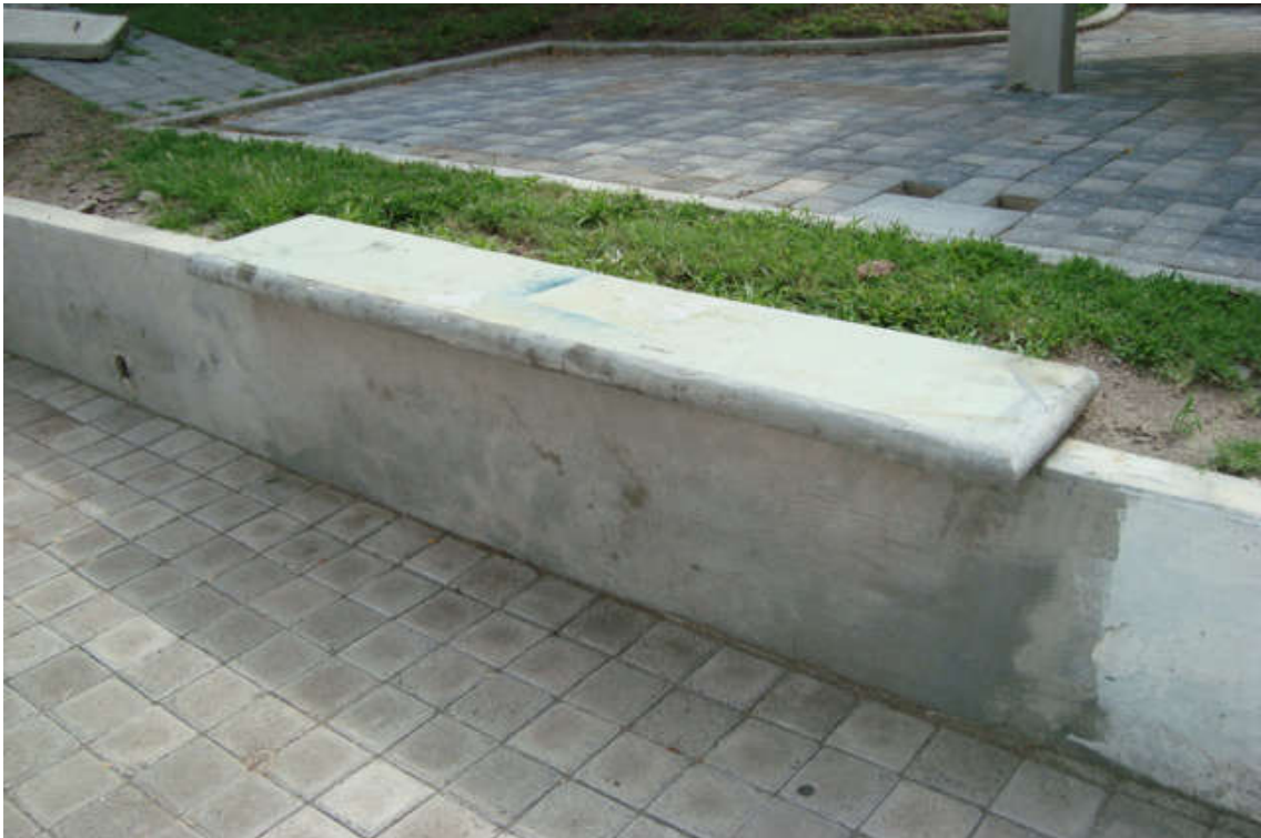
Figura 3.25. Asiento de concreto ubicado afuera del CEDIT.
