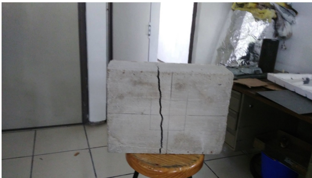
Figura 3.27. Fractura de panel.
