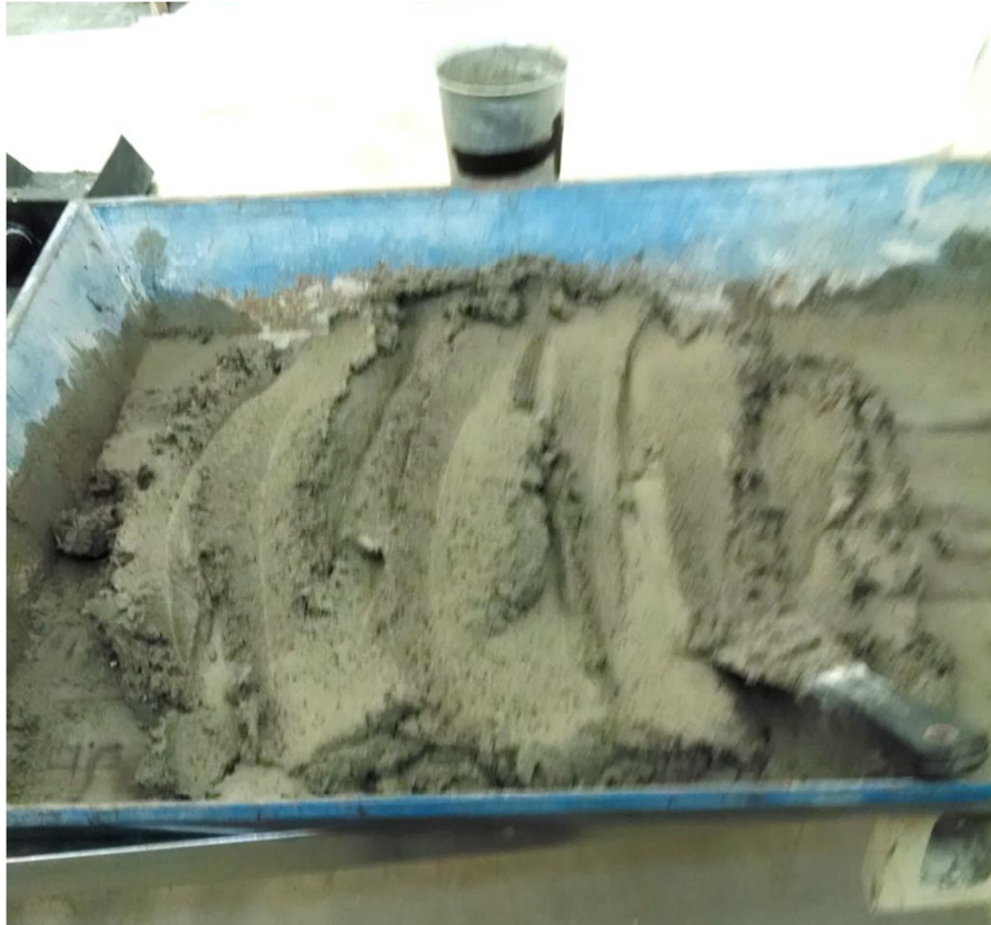
Figura 3.10. Mezcla del mortero con la consistencia adecuada.
