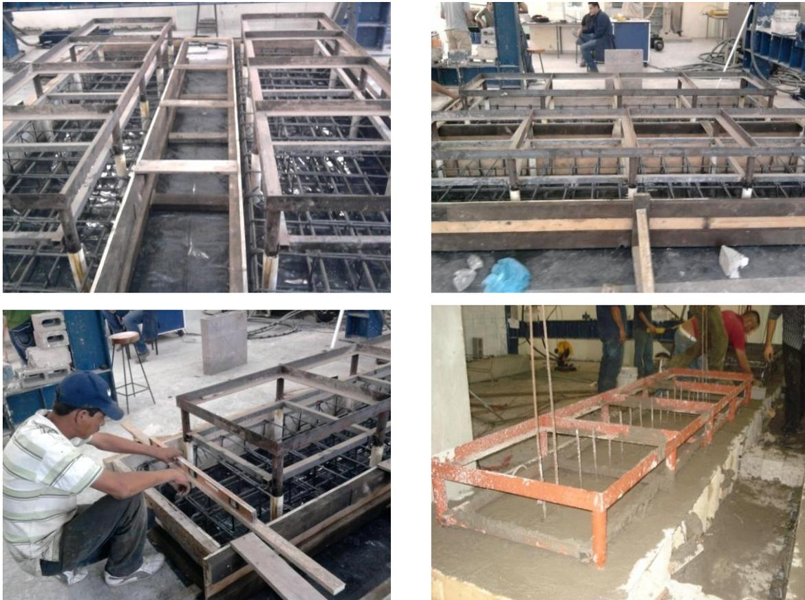
Figura 3.9 Construcción de las vigas de cimentación.
