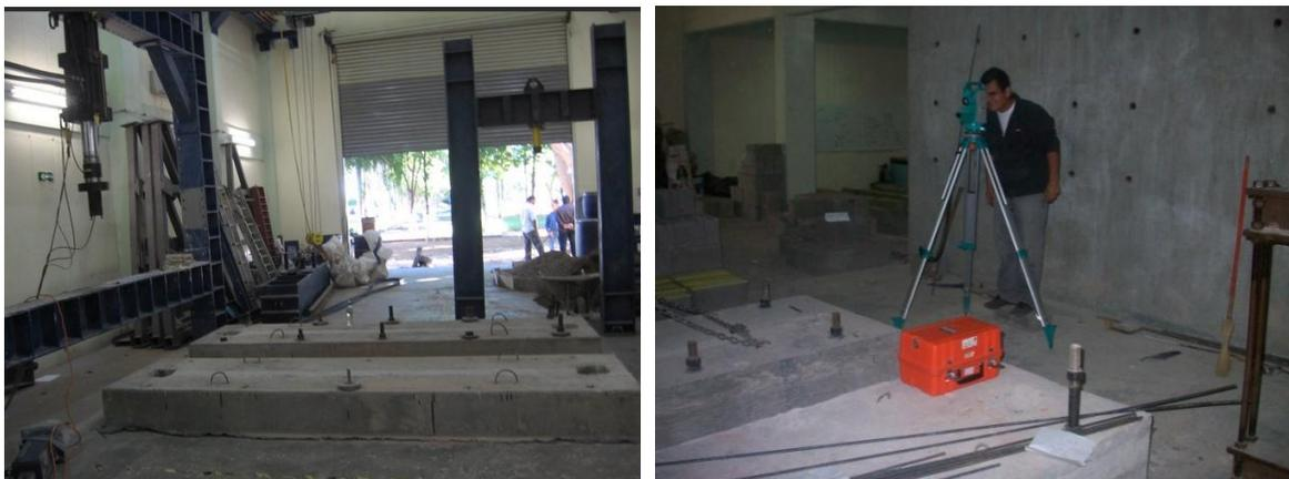
Figura 3.10 Alineación de la losas de Cimentación.
