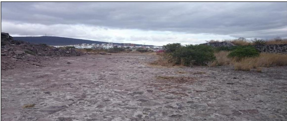
**Ilustración 21. Vista del vertedor, donde se observó vegetación creciendo entre las juntas o grietas de la mampostería.**
