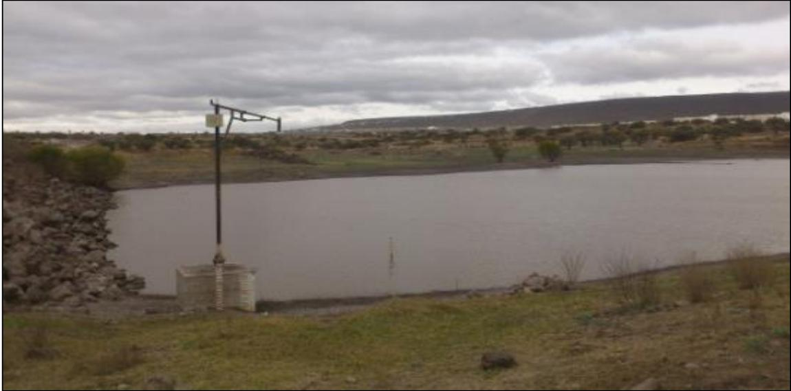
**Ilustración 20. Vista del Enrocamiento de la cortina aguas arriba.**
