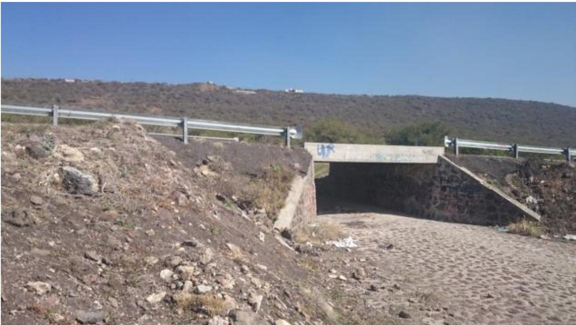
**Ilustración 13. Puentes para el paso de los escurrimientos de aguas arriba.**
