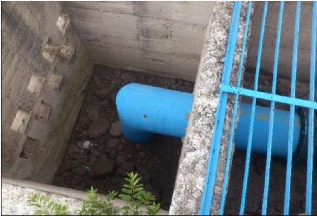
**Ilustración 26. Vista de la descarga de la obra de toma.**
