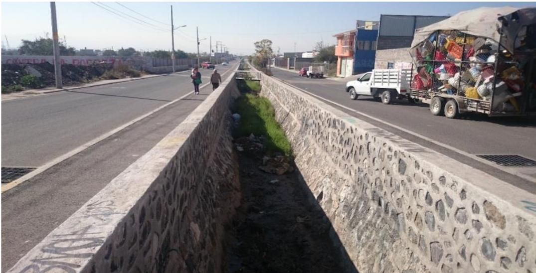
**Ilustración 9.** Canal que delimita los escurrimientos al direccionarlos hacia el Suroeste, saliendo de la cuenca de estudio.
