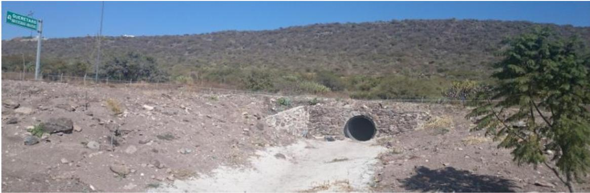
**Ilustración 14. Tubos para el paso de los escurrimientos de aguas arriba en la zona Norte del sitio de estudio.**
