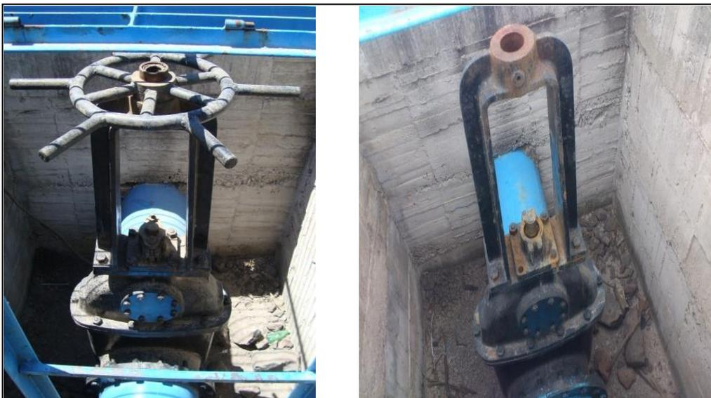
**Ilustración 25. Comparación del estado de la compuerta de la obra de toma del 2010-2014.**
