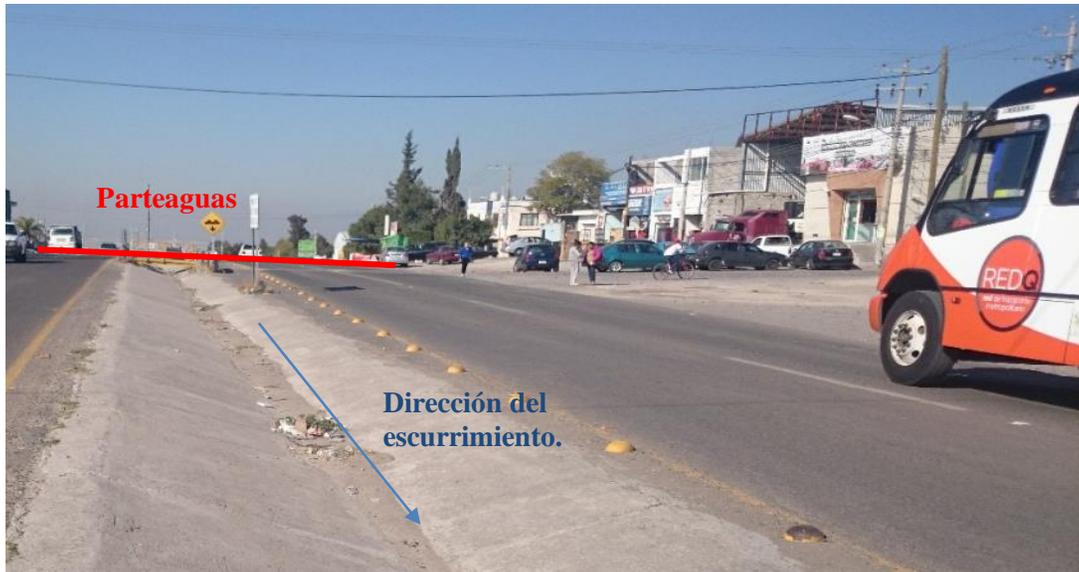
**Ilustración 8.** Se observa el parteaguas en la zona Oeste del sitio de estudio y la dirección del escurrimiento.
