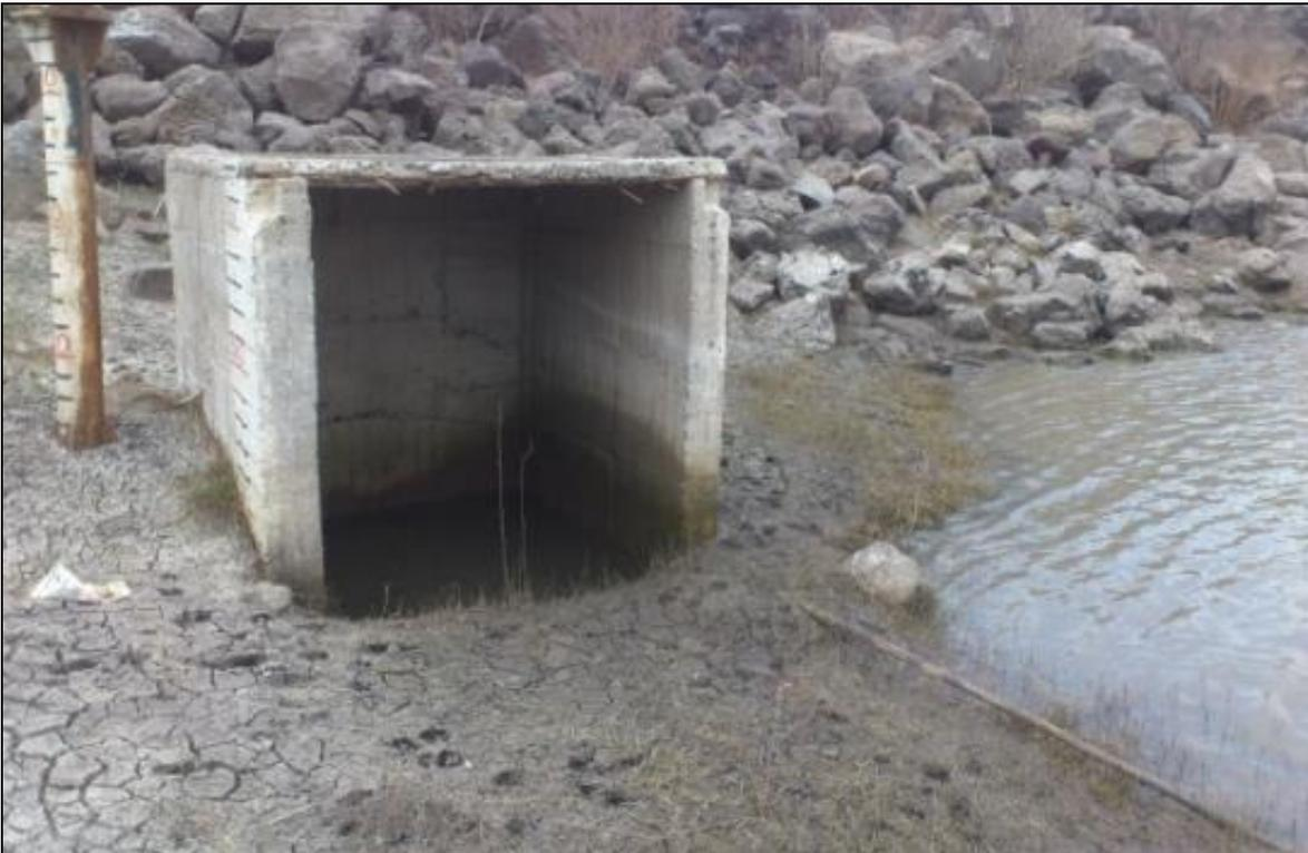
**Ilustración 22. Obra de toma aguas arriba, donde se observó, azolvada completamente y sin funcionar desde hace tiempo.**
