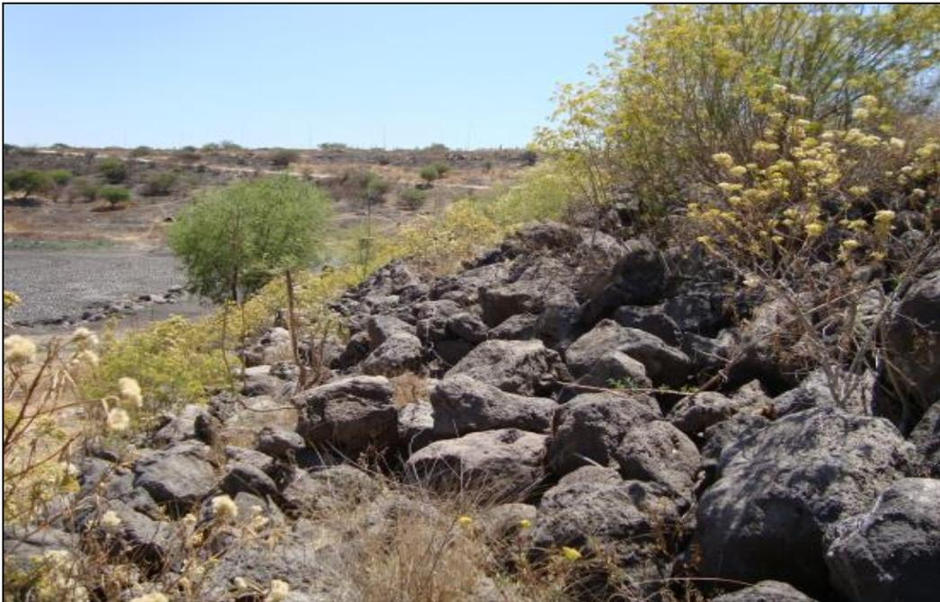
**Ilustración 2.** Vista de la corona, hombro y talud aguas abajo de la cortina.
