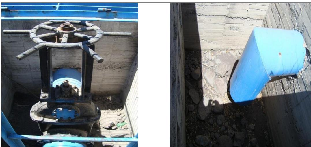
**Ilustración 5. Válvula de compuerta de la obra de toma, en la que se aprecia la falta del vástago de operación y estanque de descarga.**
