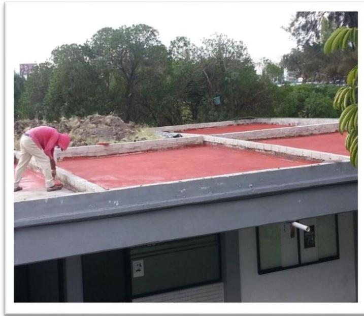
**Figura 3.17. Foto colocación de impermeabilizante**
