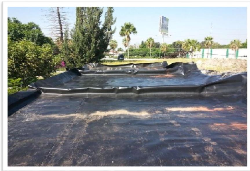
**Figura 3.18. Foto colocación de geomembrana.**
