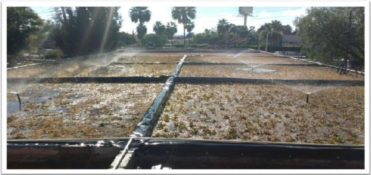
**Figura 3.19. Foto de colocación de sistema de riego, sustrato y vegetación.**
