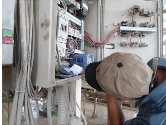
Figura 4-16 Reemplazo de un variador de frecuencia.
