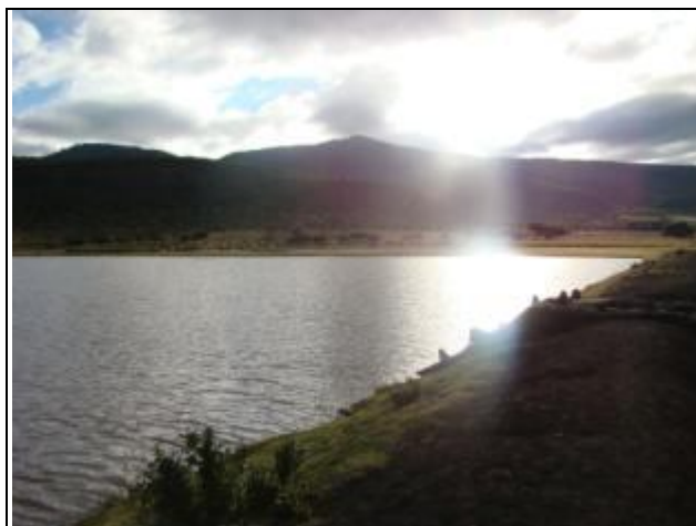
Figura 3.9. Bordo de tierra y mampostería cerca de la localidad de La Campana en la microcuenca de Sosnabar (Punto 11)
