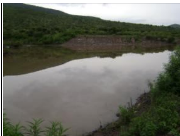
Figura 3.14. Bordo de tierra cercano a la localidad de Santa Teresita en la microcuenca de Santa Teresita de Don Diego (Punto 18)
