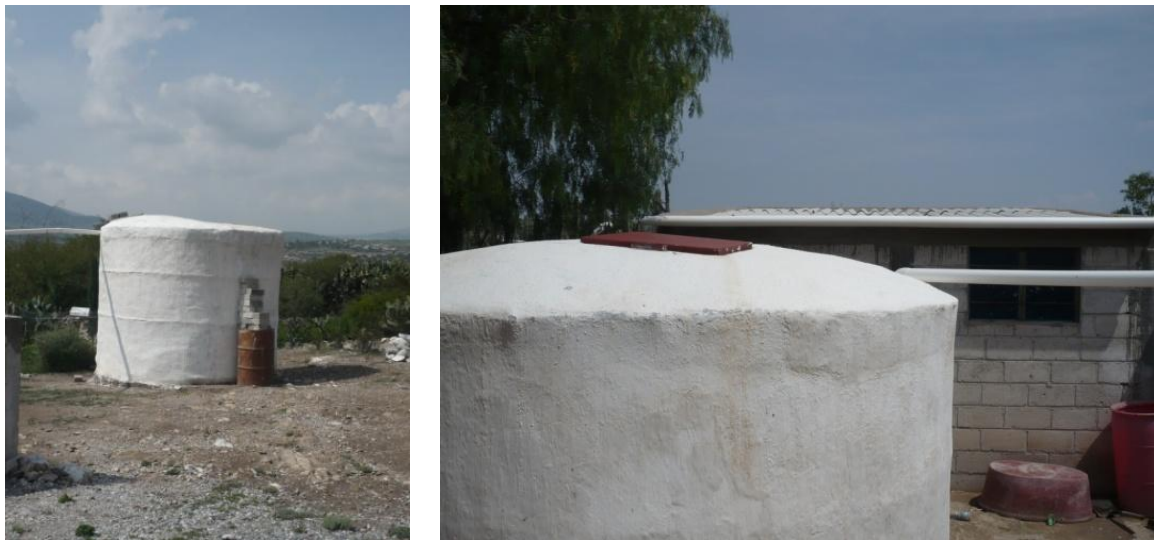
Imagen 3. Tanques de ferrocemento.
