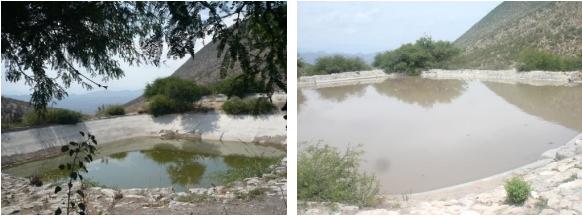
Imagen 2. Hoyas para captación de agua.
