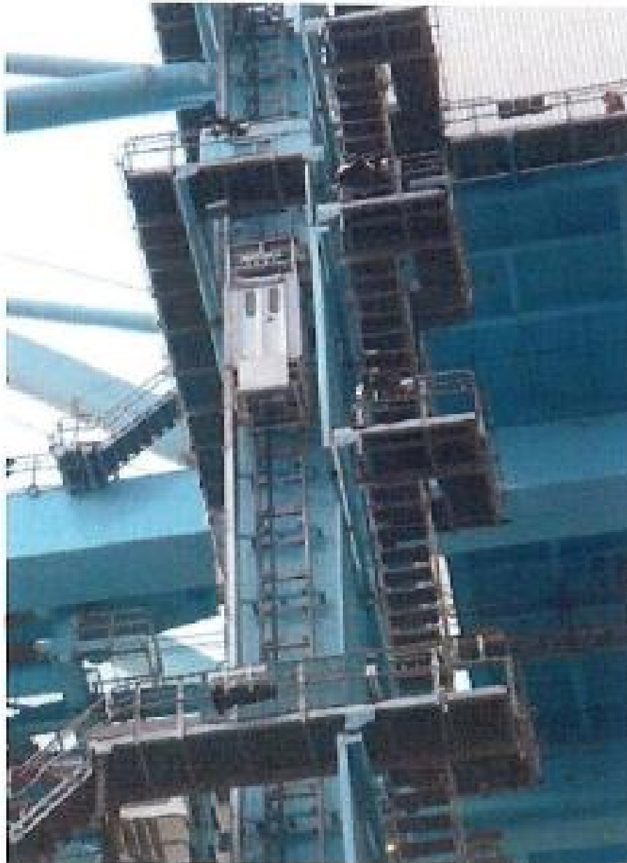
32 Figura 2.2.17 Pasillos y escaleras
