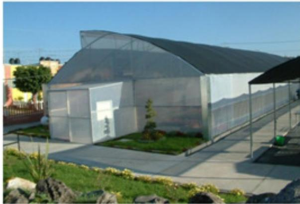
**Figura 3.1. Diseño de invernadero tipo raspa y amagado.**
