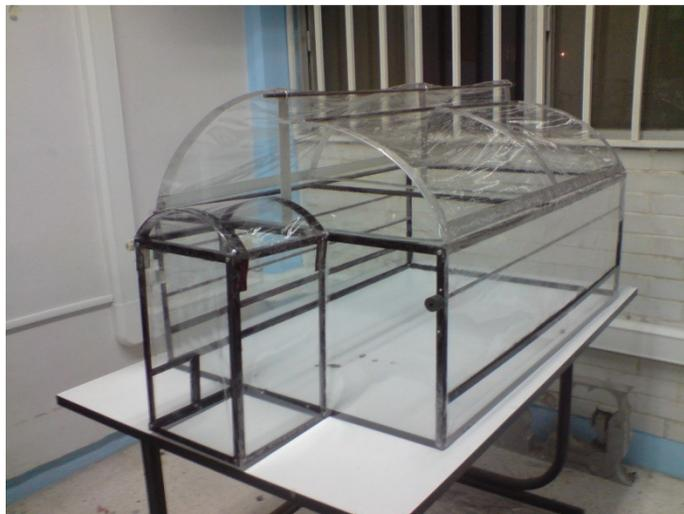
**Figura 3.12. Forrado de la estructura del invernadero.**
