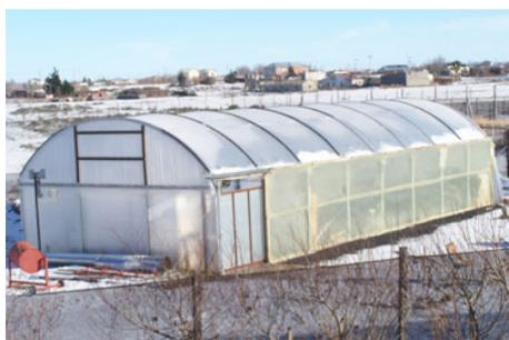
**Figura 2.6. Invernadero túnel o semicilíndrico.**
