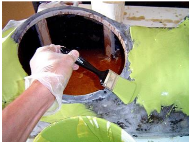
Ilustración 52 Aplicación de fibra de vidrio
