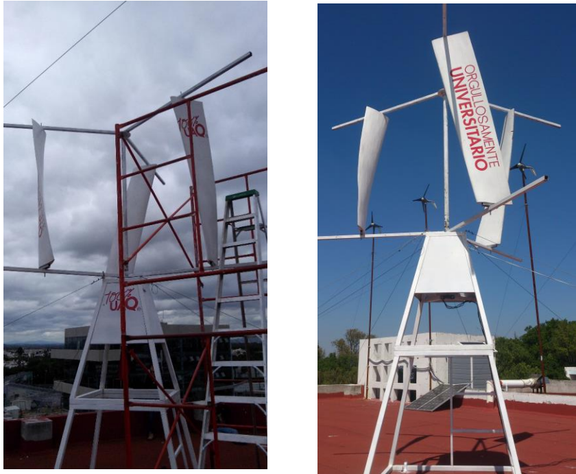
Figura 3.21 y 3.22 Montaje de aspas con modificaciones en el radio interno
