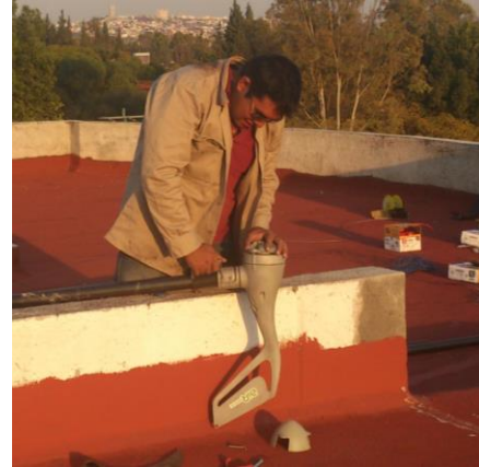
Figura 3.15 y 3.16 Instalación de aerogeneradores de eje horizontal de 200 Watts de la marca AirBreeze
