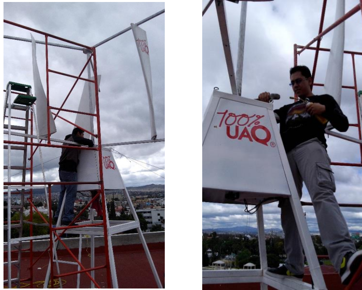
Figura 3.19 y 3.20 Montaje de torre del Aerogenerador en el techo de la Biblioteca de la Facultad de Ingeniería de la UAQ
