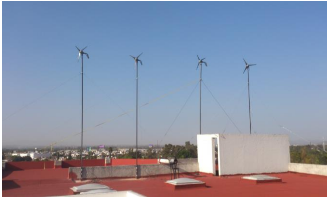
Figura 3.15 y 3.16 Instalación de aerogeneradores de eje horizontal de 200 Watts de la marca AirBreeze
