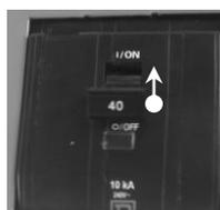
Figura 2.23. Interruptor trifásico que alimenta al centro de maquinado.
