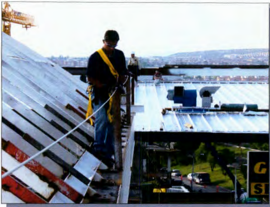
Fig. 4.9 Condiciones finales de la línea de vida al perímetro del domo colocadas de manera permanente
