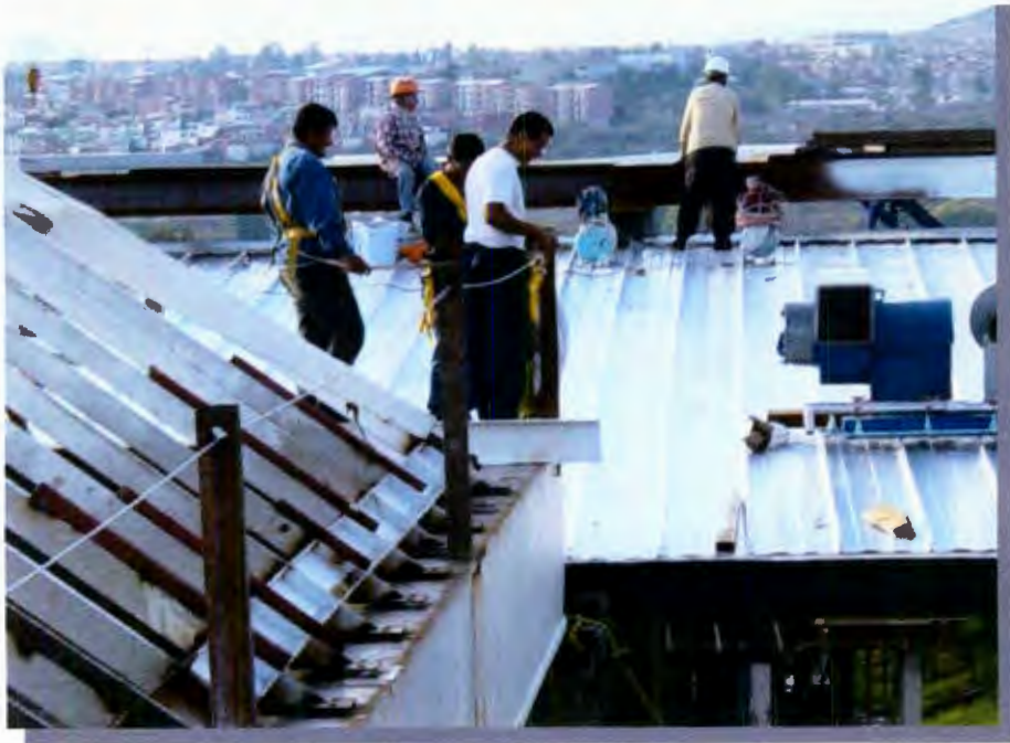
Fig. 4.6 Supervisión de las condiciones de la línea de vida al perímetro del domo
