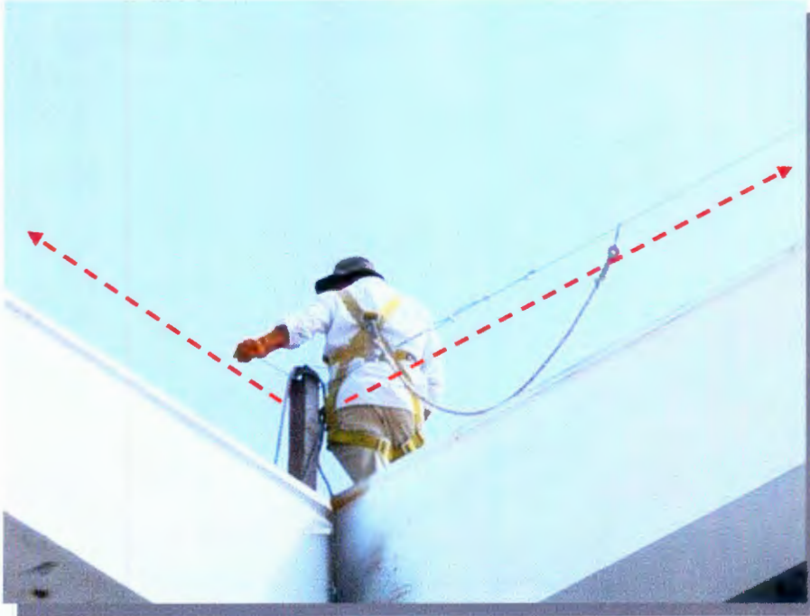
Fig. 2.1 Trabajador sujeto a la línea de vida a 16 m de altura con arnés y cabo de vida para prevención de caídas
