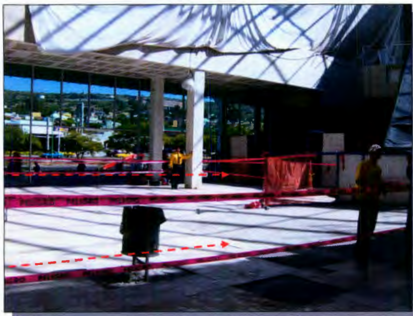
Fig. 4.13 Acordonamiento de áreas de riesgo durante el trabajo en las instalaciones del domo
