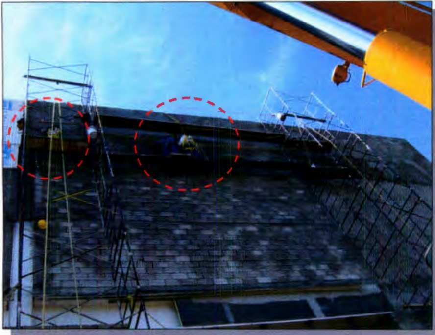
Fig. 4.10 Condiciones finales de la línea de vida y uso de equipo de prevención de caídas en trabajos no prolongados colocadas de manera provisional
