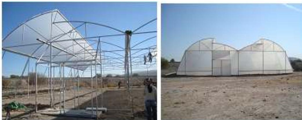
**Figura 3. 2 Cubierta del invernadero**
