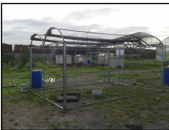
Figura 4 Estructura de PTR sin cubierta
