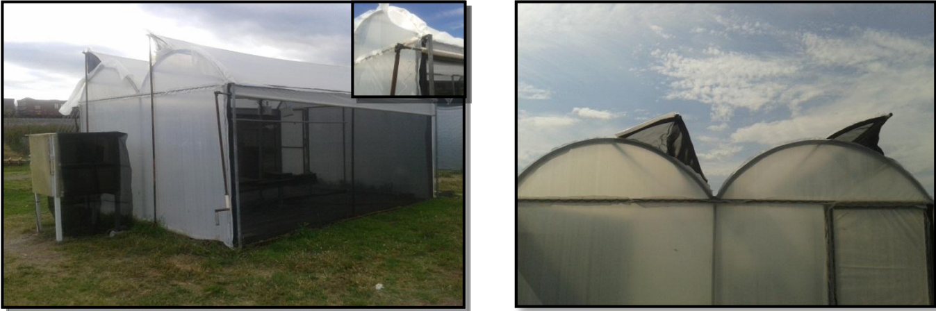
Figura 6 Invernadero control con ventanas cenitales abiertas
