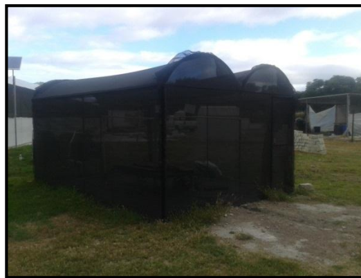
Figura 7 Estructura cubierta con malla sombra al 70%
